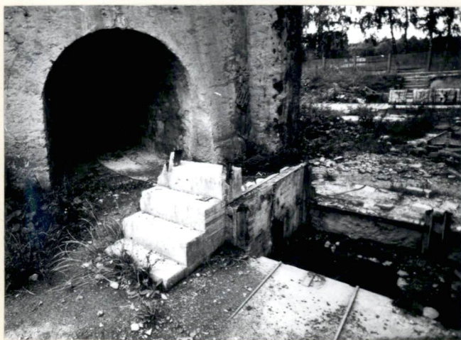
Piec 6 - otwór obsługowy od strony południowej oraz zachowane fragmenty posadowienia windy towarowej dostarczającej wagoniki ze wsadem na poziom korony /na kładkę/.
