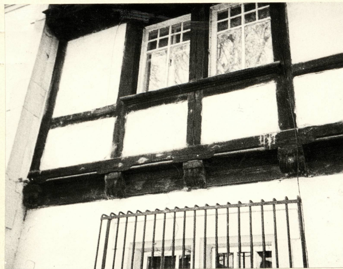
Fot. 15. Elewacja południowo-wschodnia - fragment w posadowieniu konstrukcji piętra.
