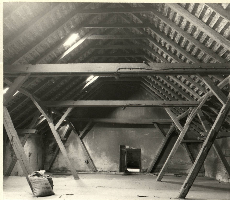
Fot.15. Stajnie, część środkowo-zachodnia. Wnętrze poddasza magazynowego → widok w kierunku zachodnim. Konstrukcja płatwiowo-kleszczowa oparta na dwurzęd- wej ukośnej ramie stolcowej, usztywnionej wysokimi ukośnymi zastrzałami i mieczmi.
