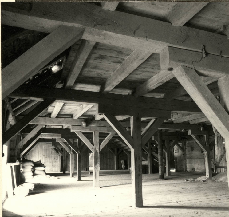
Fot.12. Stajnie, część środkowo-wschodnia. Wnętrze II kondygnacji tj. dolnej kondygnacji poddasza magazynowego nad wnętrzami /3/ i /4/ → widok w kierunku zach. Z drewna tartego. Pary słupów z mieczami i sankami podpierają podciąg poprzeczne do budynku.
