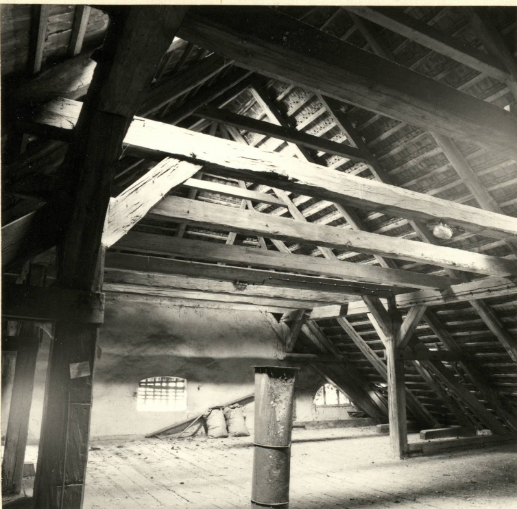
Fot.18. Spichlerz zachodni → wnętrze III kondygnacji → poddasze magazynowe, widok w kierunku zachodniej ściany szczy- towej. Oryginalna więźba dachowa, z drewna ciosanego, łączonego na zamki ciesielskie i kołki (jedynie boczne zastrzały ukośne i kleszcze są z drewna tartego, łączone na stalowe śruby z podkładkami. Konstrukcja typu stolcowego, oparta na dwurzędowej ra- mie. Co trzeci więźar jest pełny. Słupy usztywnione podłużnie z płatwią parą mie- czy i poprzecznie mieczem z jętką i wyso- kim ukośnym zastrzałem dołem osadzonym w wzmocnieniu belki więzarowej.
