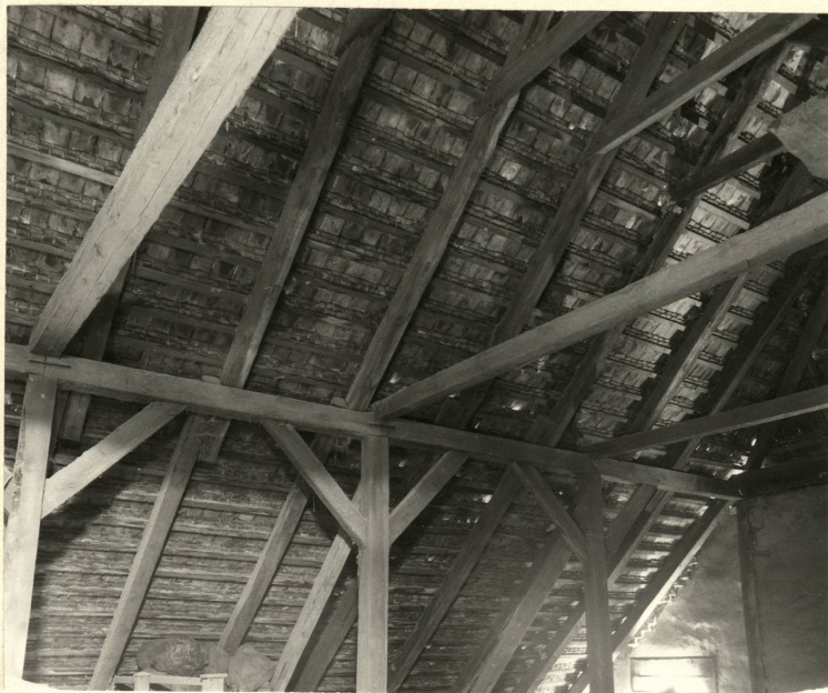
Fot.9. Spichlerz wschodni → wnętrze III kondygnacji → poddasze magazynowe; widok w kierunku pn-wschodnim. Więźba dachowa nowsza, z drewna tartego, ze znakami ciesielskimi, konstrukcji płatwiowej, oparta na dwurzędowej ramie stolcowej, co drugi, co trzeci więzar pełny; słupy z mieczami usztywnione jętką i każdy długim ukośnym zastrzałem. Krokwie łączone.
