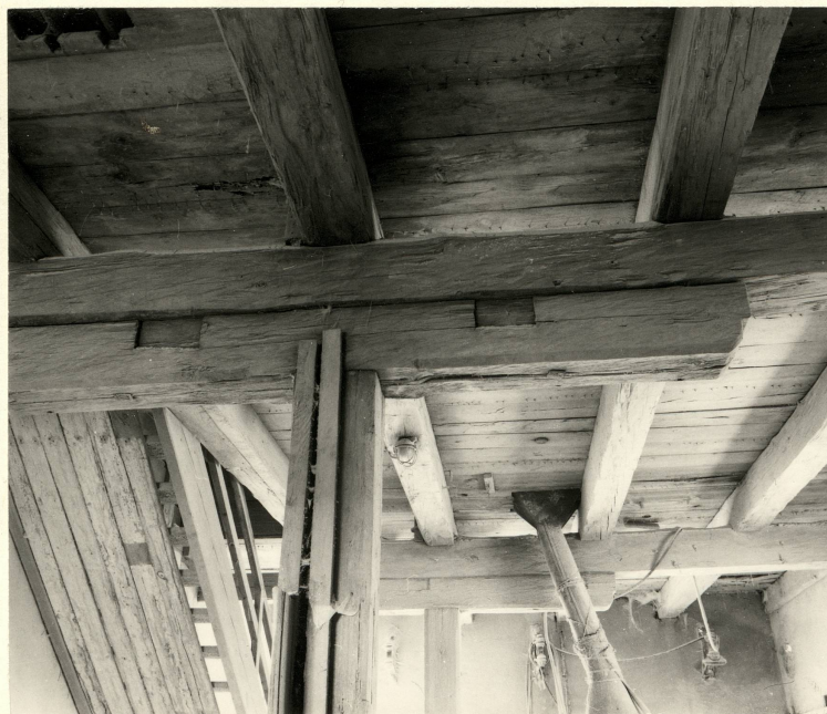
Fot.7. Spichlerz wschodni - wnętrze /1/ w przyziemiu, tj. dolna kondygnacja → strop drewniany, belkowy, nagi, podparty dwoma podciągami leżącymi na sankach podpartych słupami → widok ku północy.
