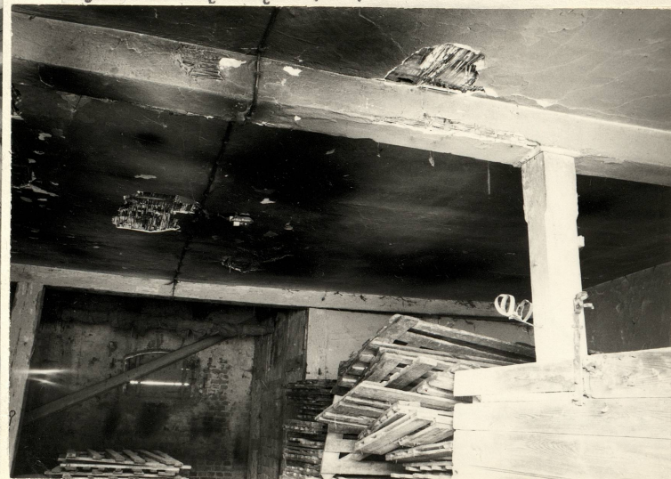
Fot.16. Spichlerz zachodni → wnętrze przy- ziemia → widok ogólny w kierunku południowym. Wnętrze nakryte stropem dREW- nianym, pierwotnie belkowym na dwóch pod- ciągach podpartych drewnianymi słupami, obecnie na strop w części /10/ nałożona jest podsufitka. W głębi z lewej strony - strop belkowy nago /9/ i z prawej widać wydzieloną część /11/.
