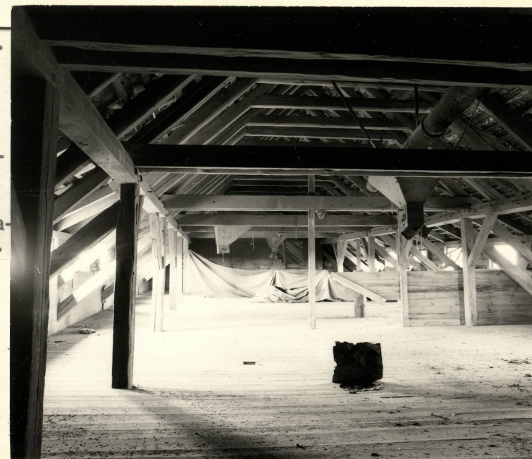
Fot.13. Stajnie, część środkowo-wschodnia. Wnętrze III kondygnacji, czyli górnej kondygnacji poddasza magazynowego → widok w kierunku zachodnim. Konstrukcja płatwiowo-kleszczowa, oparta na dwurzędowej ramie stolcowej, usztywniające poprzecznie pary długich kleszczy obłapują krokwie nad płatwiami połaciowymi; słupy z parami mieczy usztywnione ukośnymi zastrzałami dochodzącymi dołem do II kondygnacji.
