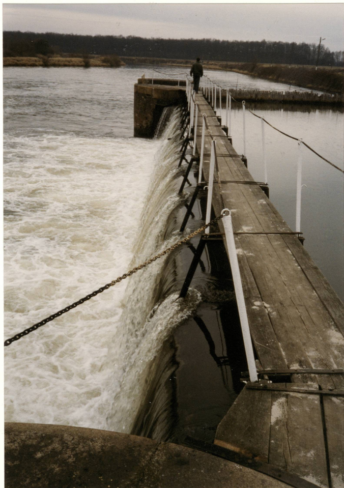
4. Kładka nad progiem stałym łączącym przesło lewe i prawe jazu, neg. 1100/752/1
