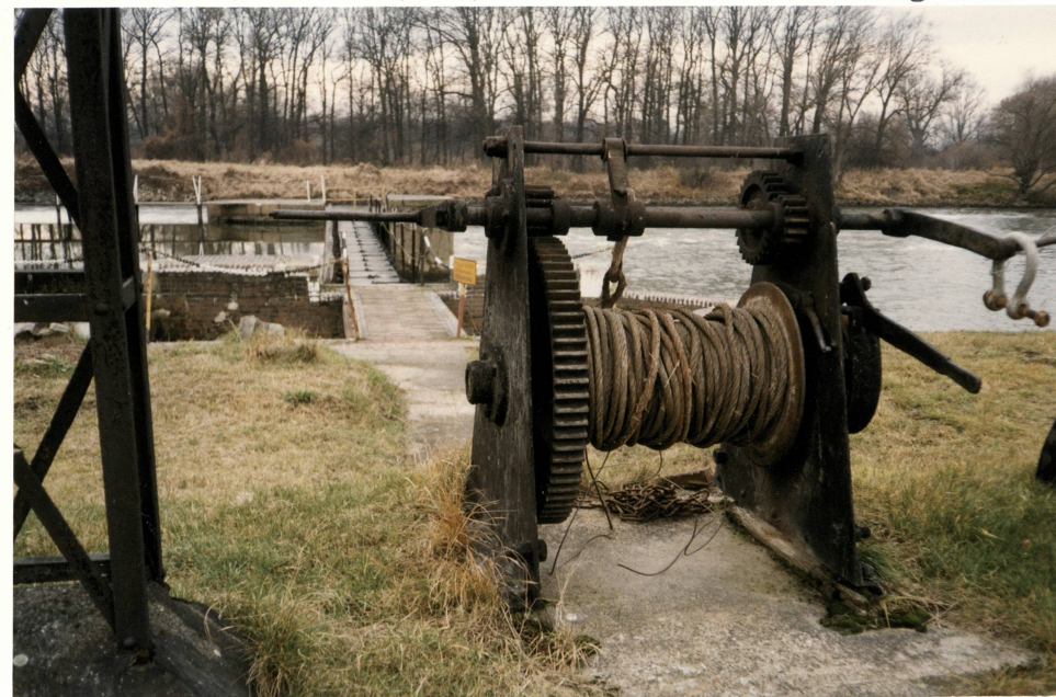
7. Ręczna wciągarka do kładzenia i podnoszenia kozłów przęsła prawego, neg. 1100/745/4
