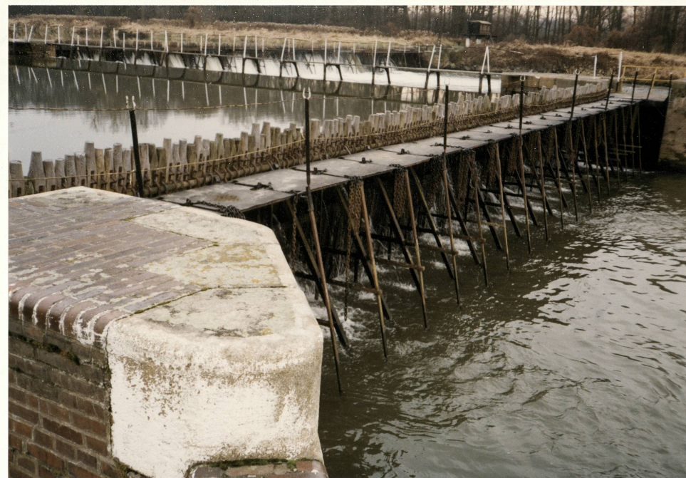
5. Przęsło prawe jazu od dolnej wody z kozłami o rozstawie 1,22 m, neg. 1100/743/2
