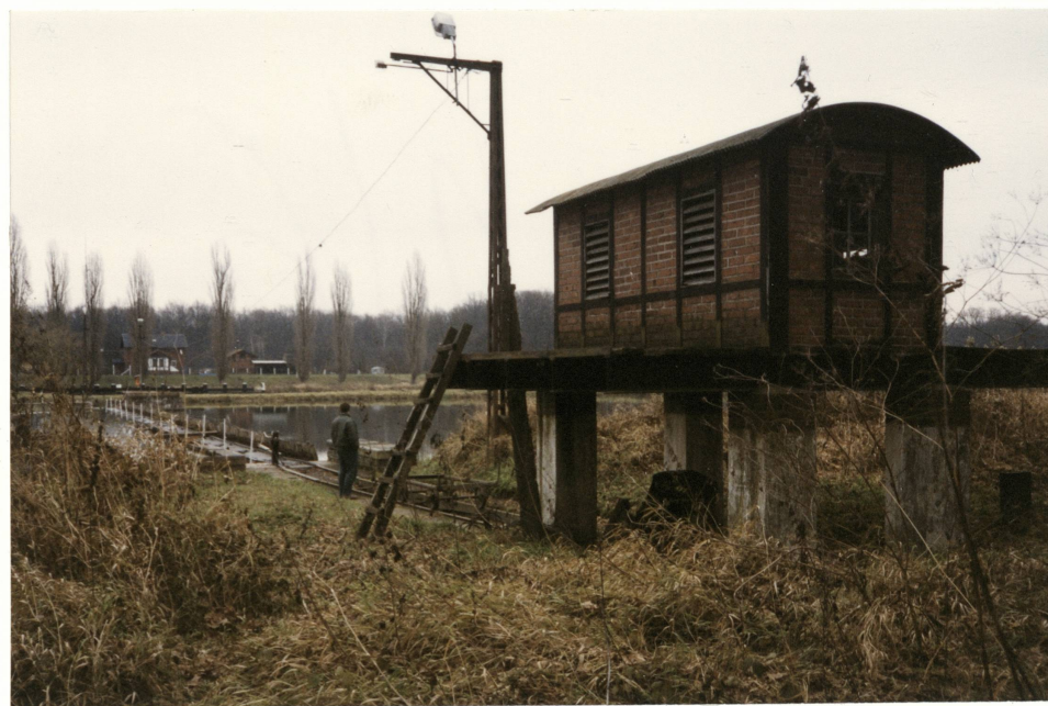
6. Pomieszczenie wciągarki ręcznej do podnoszenia i kładzenia kozłów w lewym przęśle jazu, neg. 1100/750/3
