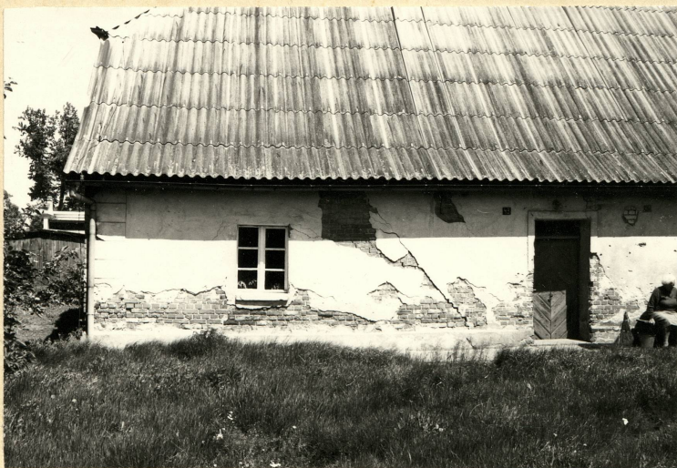
Fot.3. Zachodnia część elewacji południowej - spękanie.
