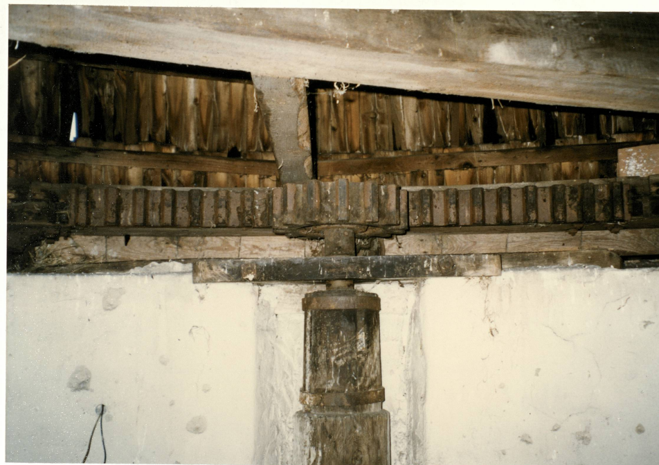
4. Przekładnia mechanizmu obrotu dachu wiatraka, neg. 600/521/3.
