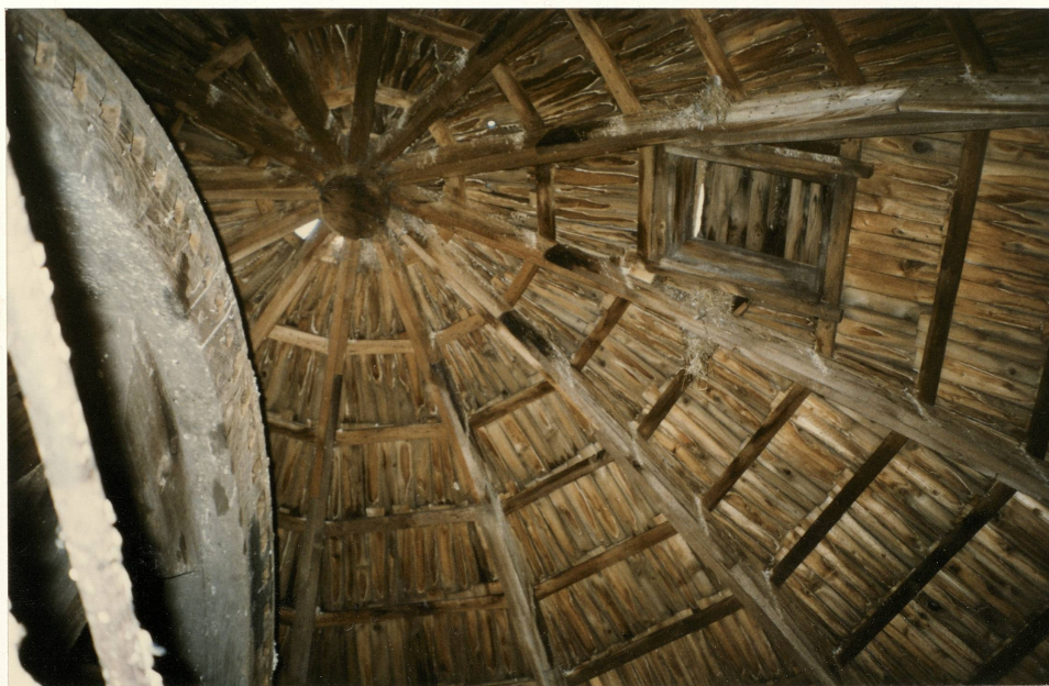
4. Konstrukcja dachu; z lewej strony fragment koła palecznego, neg. 600/521/1.
