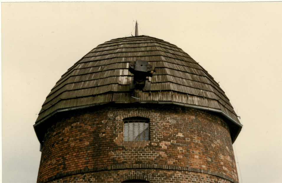
4. Konstrukcja dachu; z lewej strony fragment koła palecznego, neg. 600/521/1.
