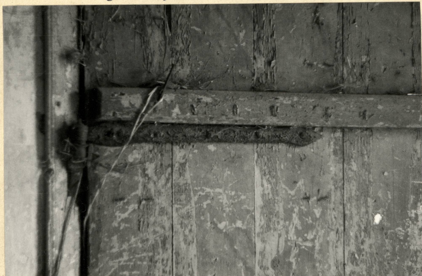
Fot.14. Zawias drzwi deskowo-szpungowych głównych wejściowych do budynku.
