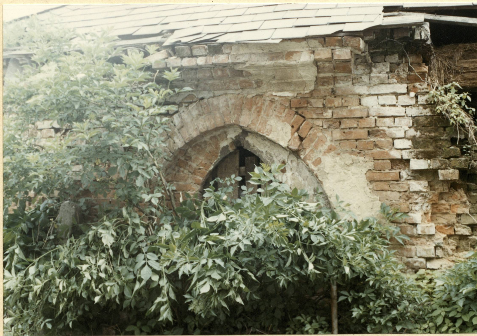
Fot. 8. Fragment elewacji południowej - ostrołuczny otwór okienny w ostrołucznej blendzie.
