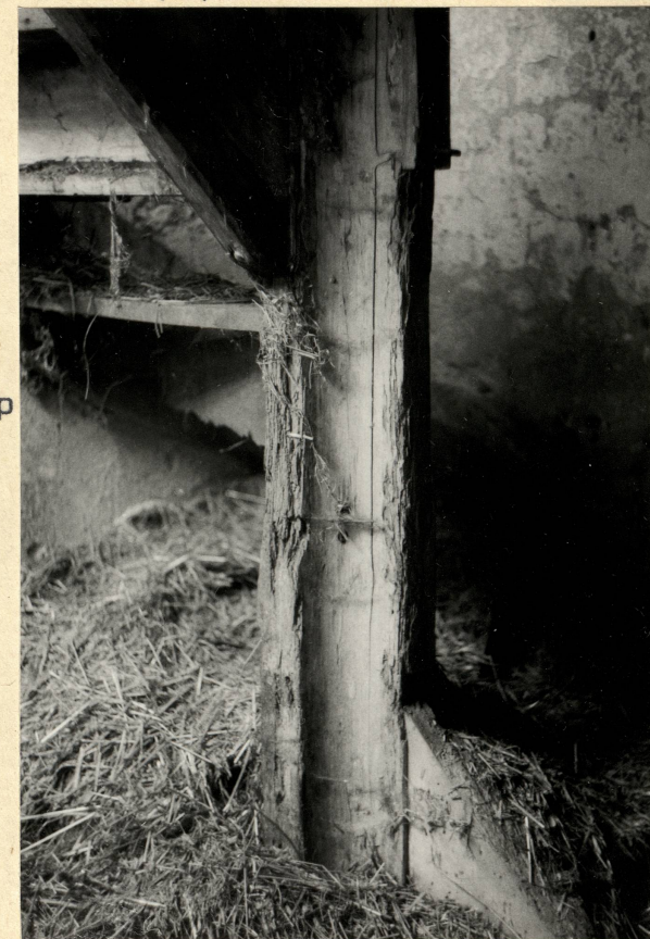
Fot.13. Brakująca część schodów w sieni /1/.
