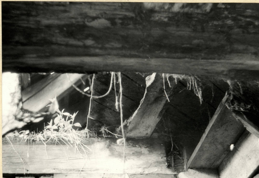
Fot.13. Brakująca część schodów w sieni /1/.
