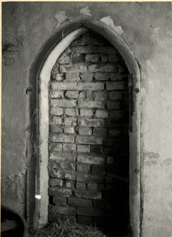
Fot.16. Wnętrze pomieszczenia narożnego pd.-wsch. ostrołuczny otwór (?) drzwi - obecnie zamurowane.
