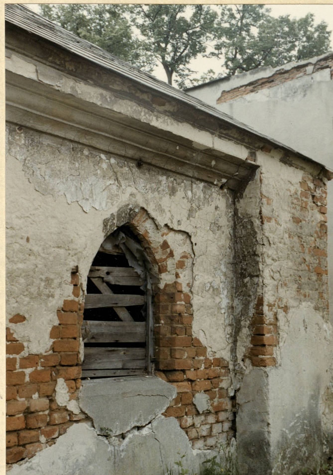
Fot.3. Fragment elewacji głównej zachodniej - narożna lizena południowa i profil murowanego gzymsu koronującego i otwór okienny.
