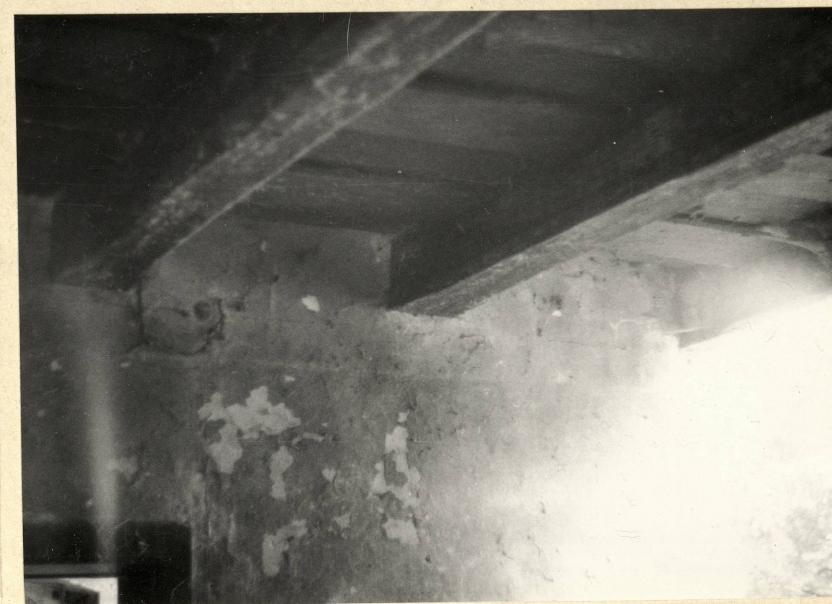
Fot.11. Wnętrze pomieszczenia /6/ - fragment drewnianego stropu belkowego opartego na wewnętrz- nej ścianie działowej.
