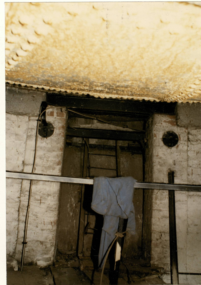
6. Partia podziornikowa wieży, widoczny zbiornik nitowany i wyjście prowadzące do głowicy wieży wokół zbiornika, neg. 700/12/5.
