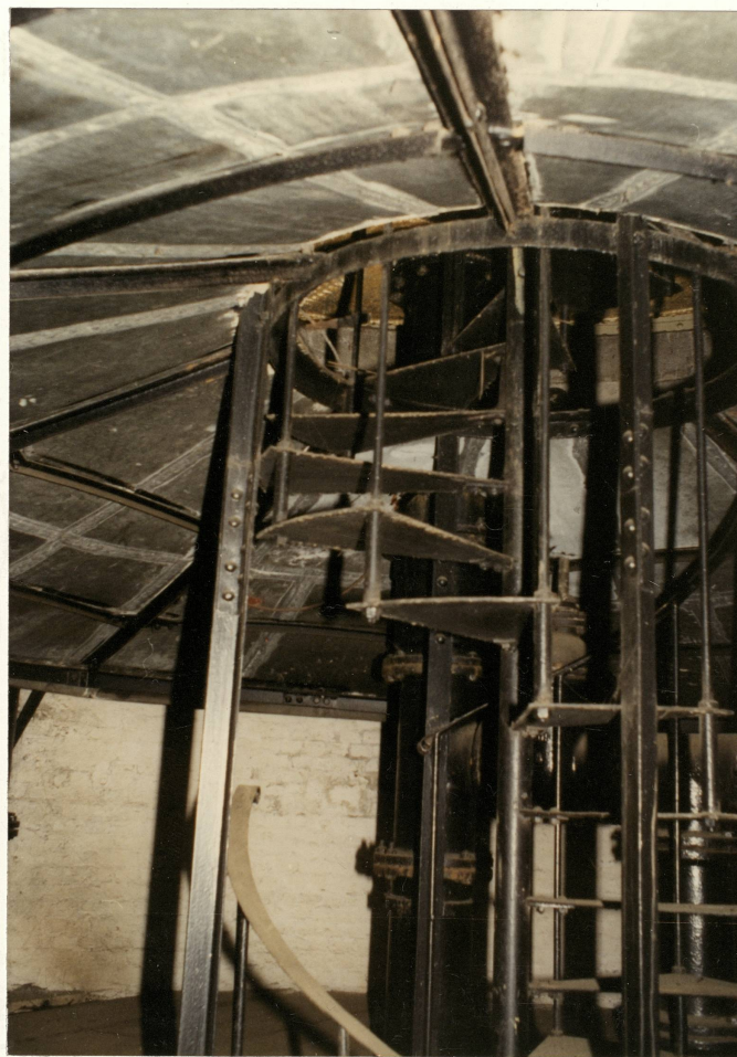
5. Partia podziornikowa wieży, widoczny blaszany łącznik skroplin, neg. 700/12/4,
