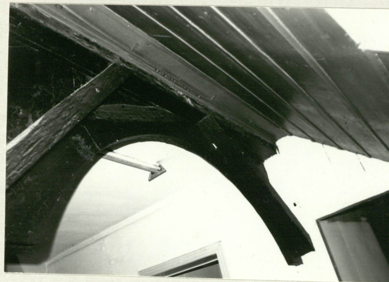
Mieczowanie więźby w użytkowym poddaszu
