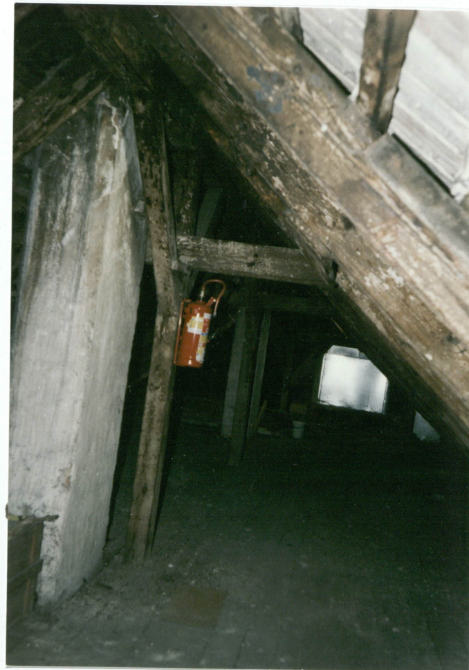
wieżba dachowa – elementy krokwi
