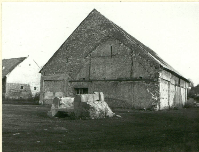
Fot. 6. Budynek dawnych młynów wapna, ob. magazyn. Widoczny zarys na ścianie szczytowej rozebranego budynku kotłowni, na pierwszym planie zachowany fragment fundamentu pieca. Widok od strony zachodniej.
