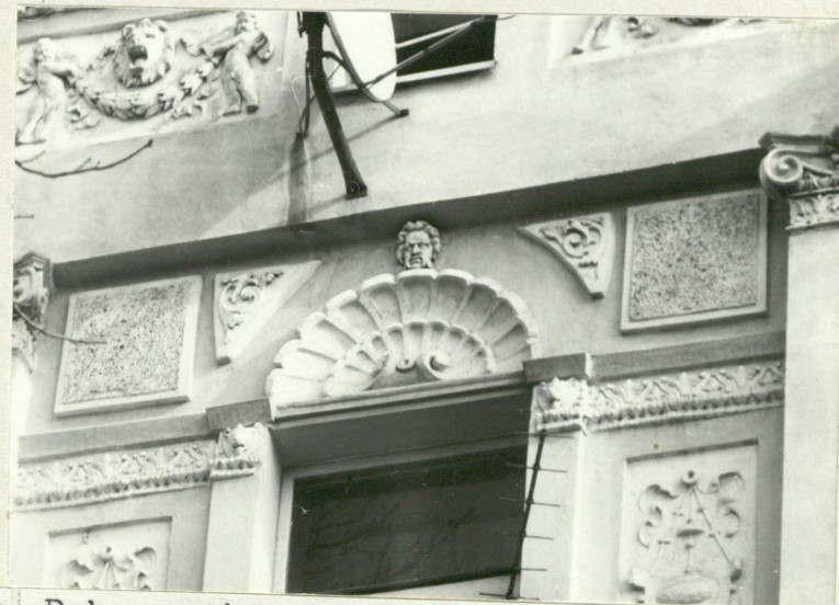
II i III kondygn. ryzalitu Płycina i gzyms kostkowy dźwigający attykę Dekoracyjna muszla zwieńczenia okna w ryzalicie
