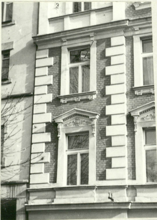
II i III kondygn. ryzalitu Płycina i gzyms kostkowy dźwigający attykę Dekoracyjna muszla zwieńczenia okna w ryzalicie
