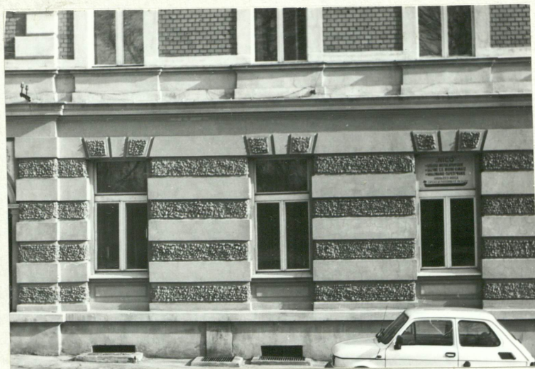
Boniowanie i okna parteru
