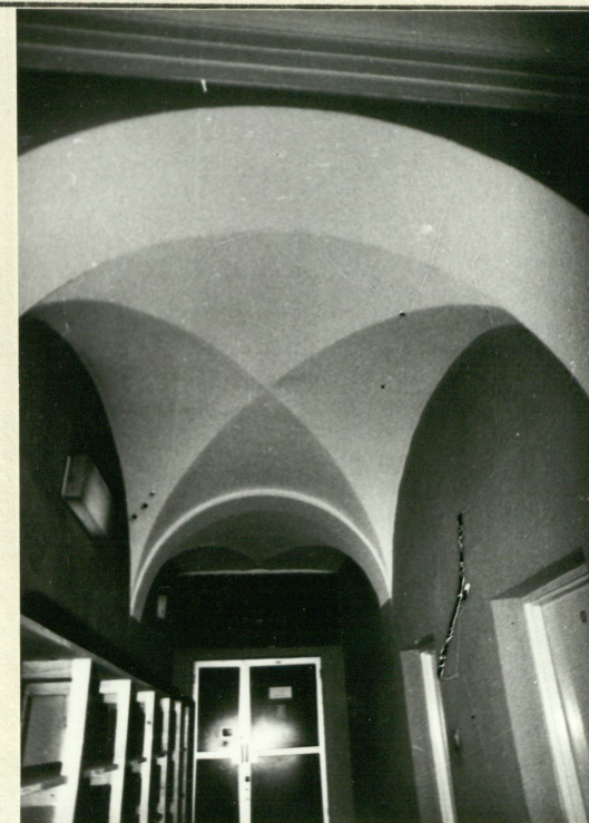
18. Sklepienie w korytarzu na II kondygn. część wsch.
