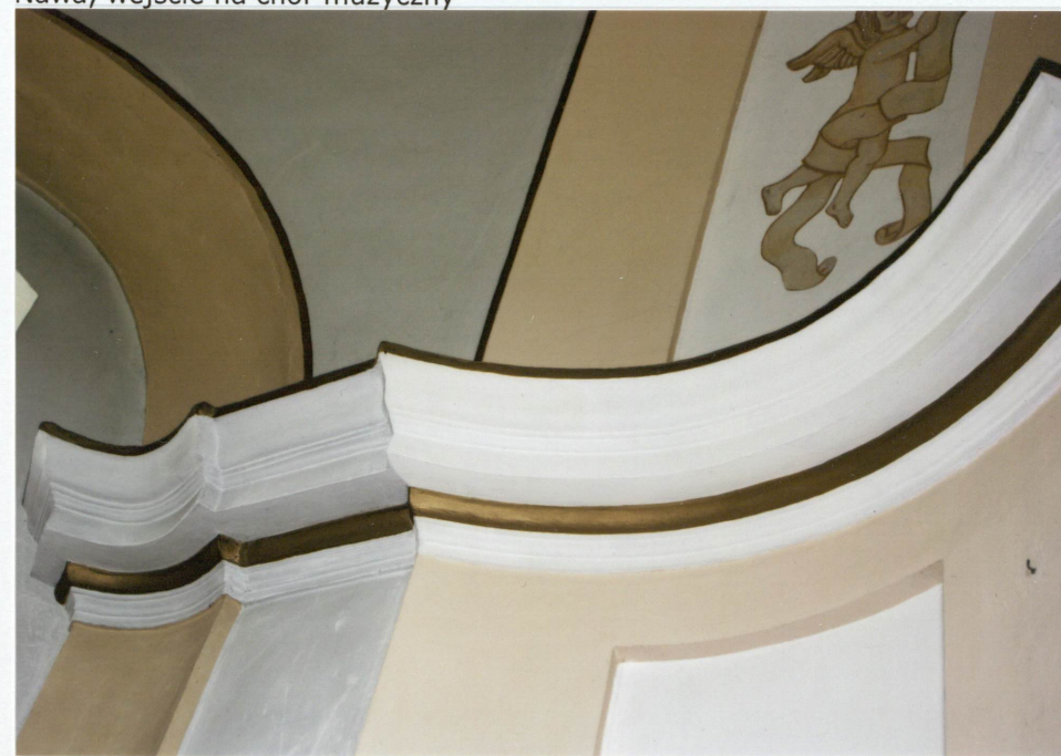
Profil gzymsów wieńczących pilastry.
