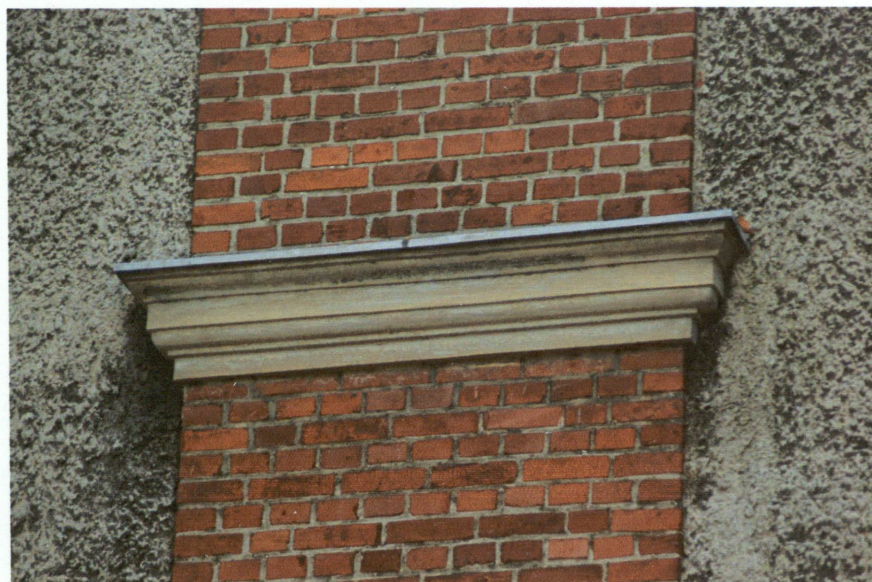
Profil gzymsu na lizenach w elewacji północnej.
