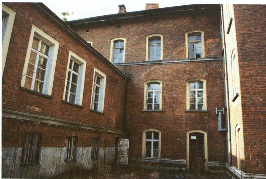
4 i 5-ta oś okienna elewacji wschodniej z widocznymi śladami po nieistniejących schodach zewnętrznych.
