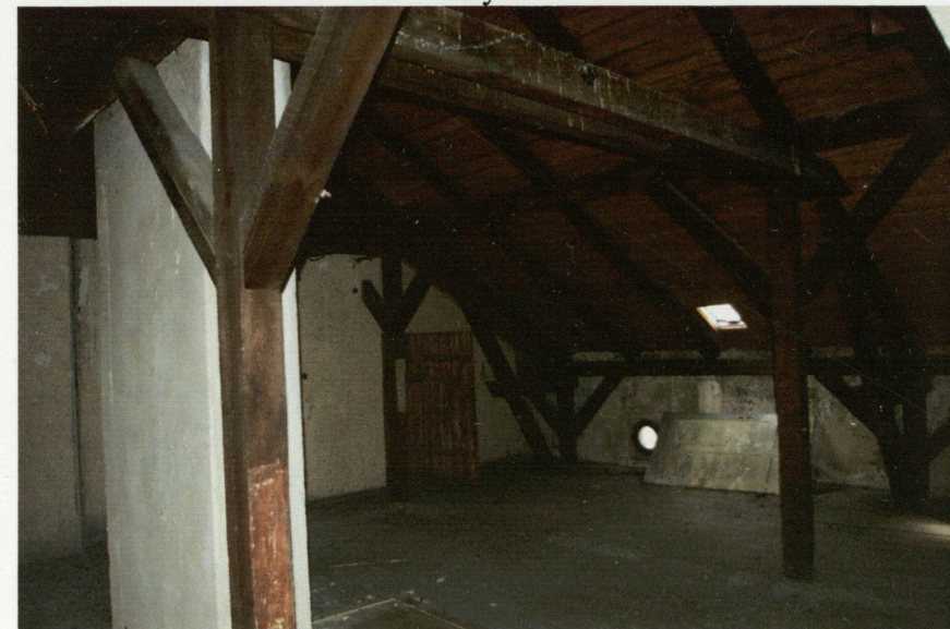
Konstrukcja więźby dachowej.
