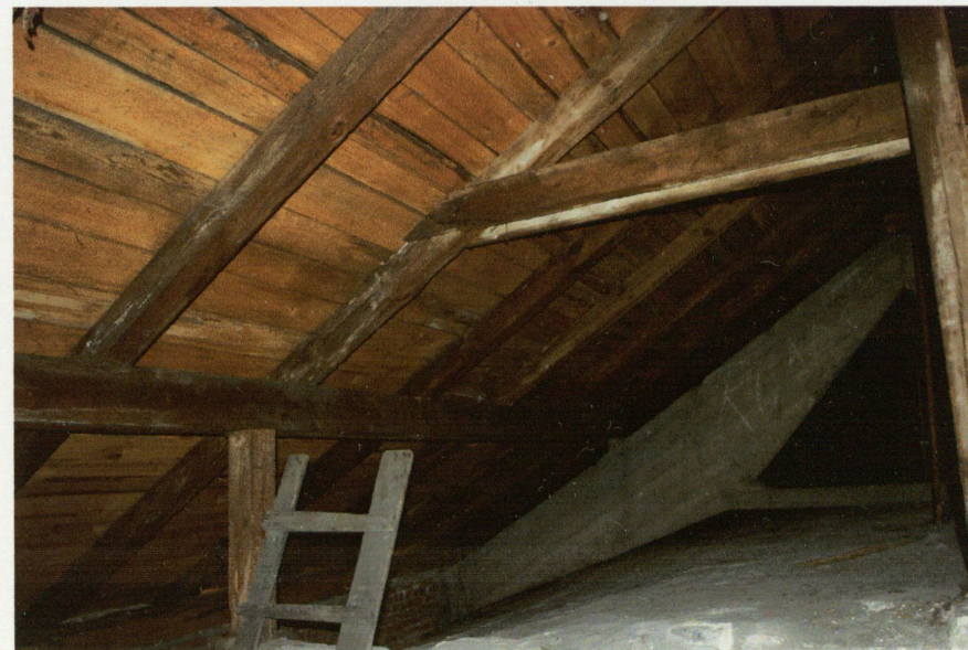
Konstrukcja więźby dachowej.
