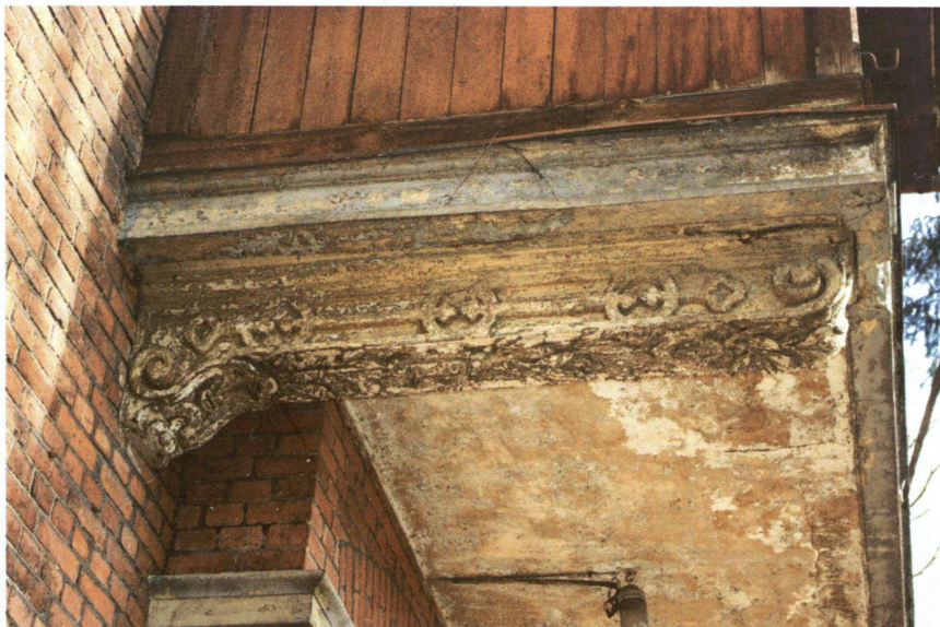
Konsola wspierająca płytę balkonową.
