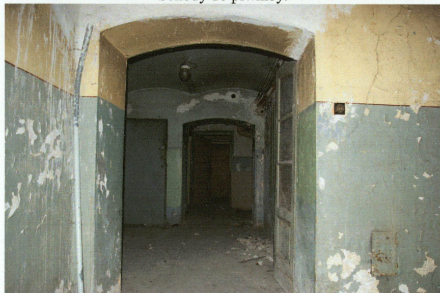
Łęki nadproży w pomieszczeniach piwnicznych.
