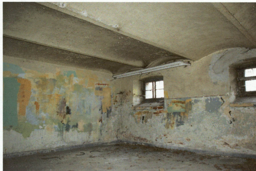
Strop odcinkowy typu Kleina w piwnicy.
