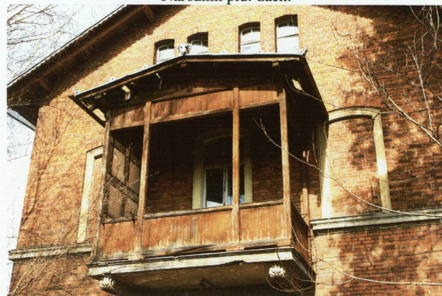
Wsparty na konsolach balkon w II kondygnacji elewacji południowej.
