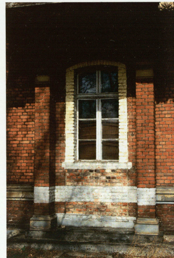
Portal w elewacji południowej – obecnie otwór drzwiowy przekształcony w okno.
