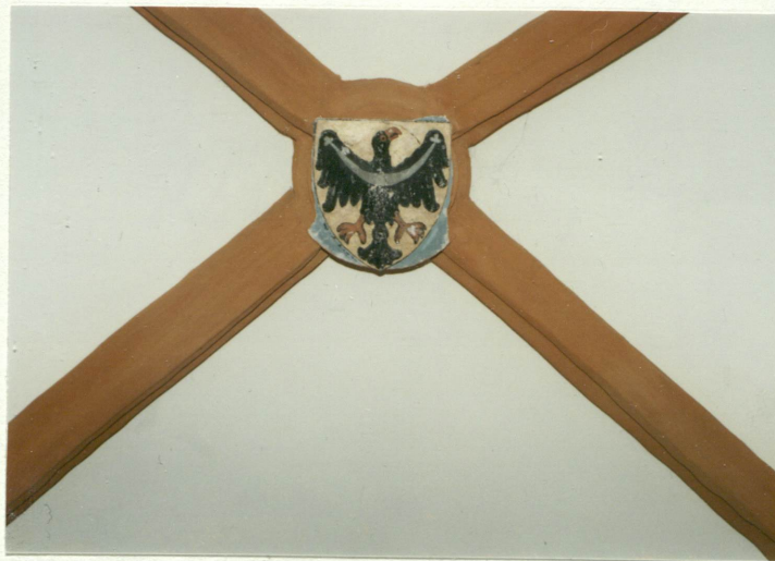
Zwornik sklepienia empory
