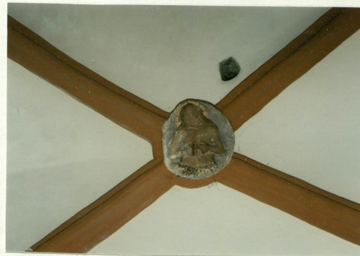
Zwornik sklepienia empory
