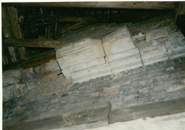
Poddasze - gzyms bramy zamkowej
