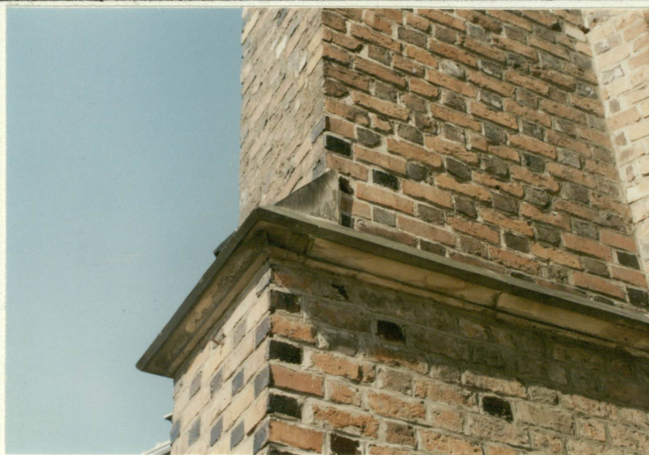
Absyda gotycka - gzyms kapnikowy skarpy
