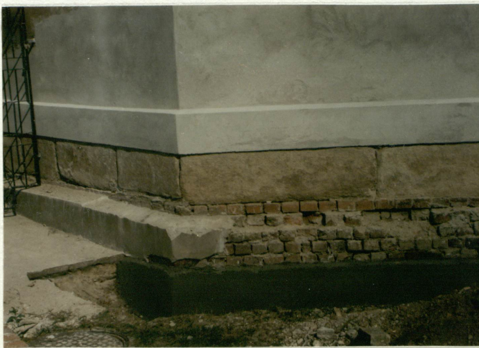
Fundament i cokół części barokowej
