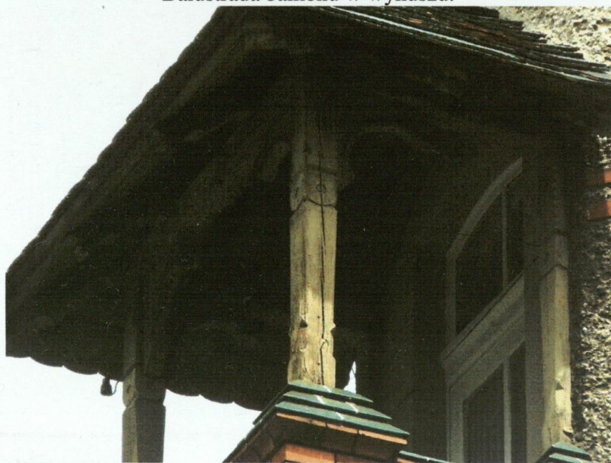
Drewniana konstrukcja wsporcza daszku nad wykuszem.
