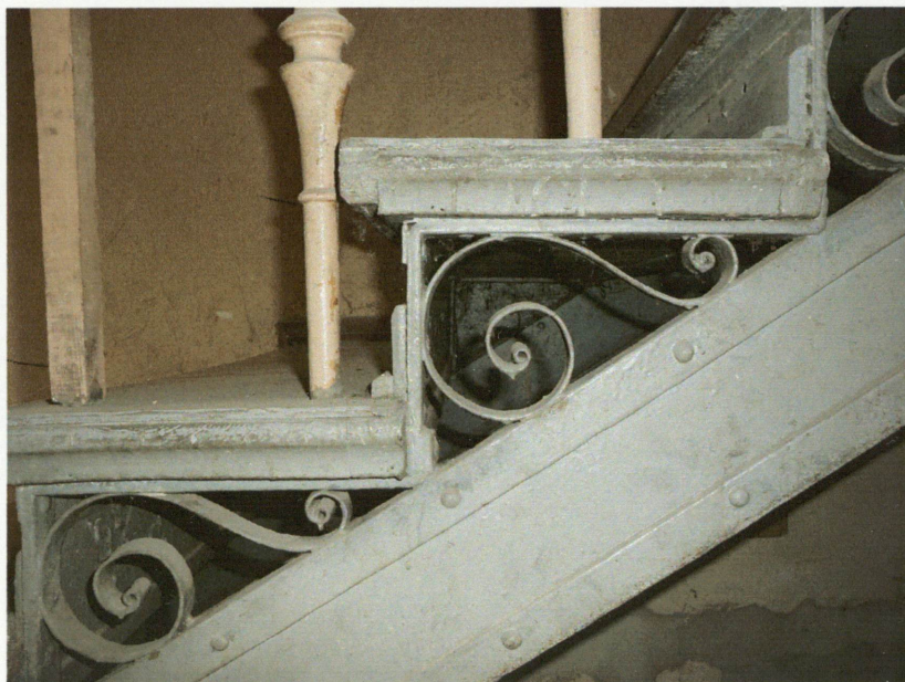
Stalowa konstrukcja i dekoracja schodów.
