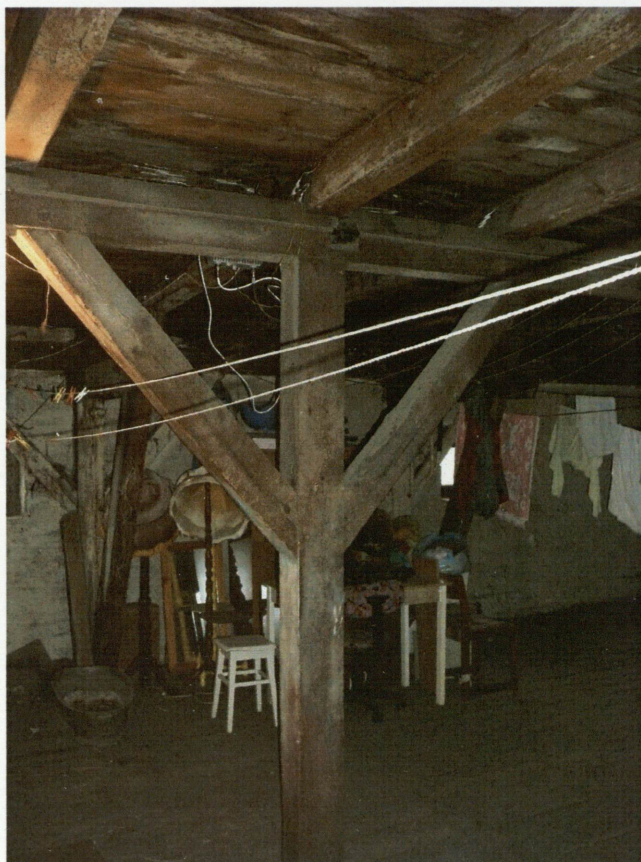
Drewniana konstrukcja więźby dachowej.
