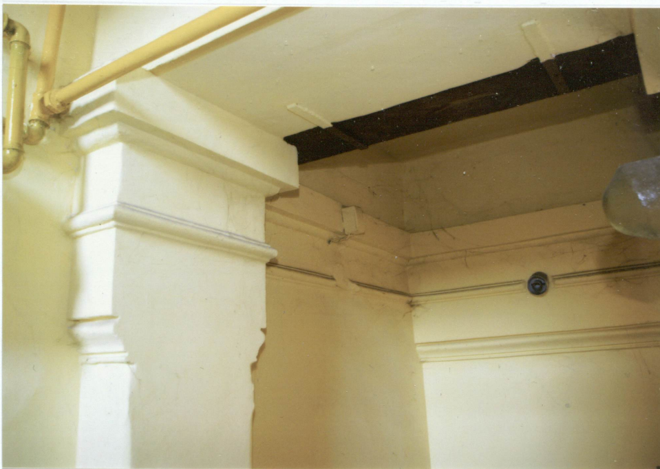
Pilastry wspierające podciąg w bramie przejazdowej.
