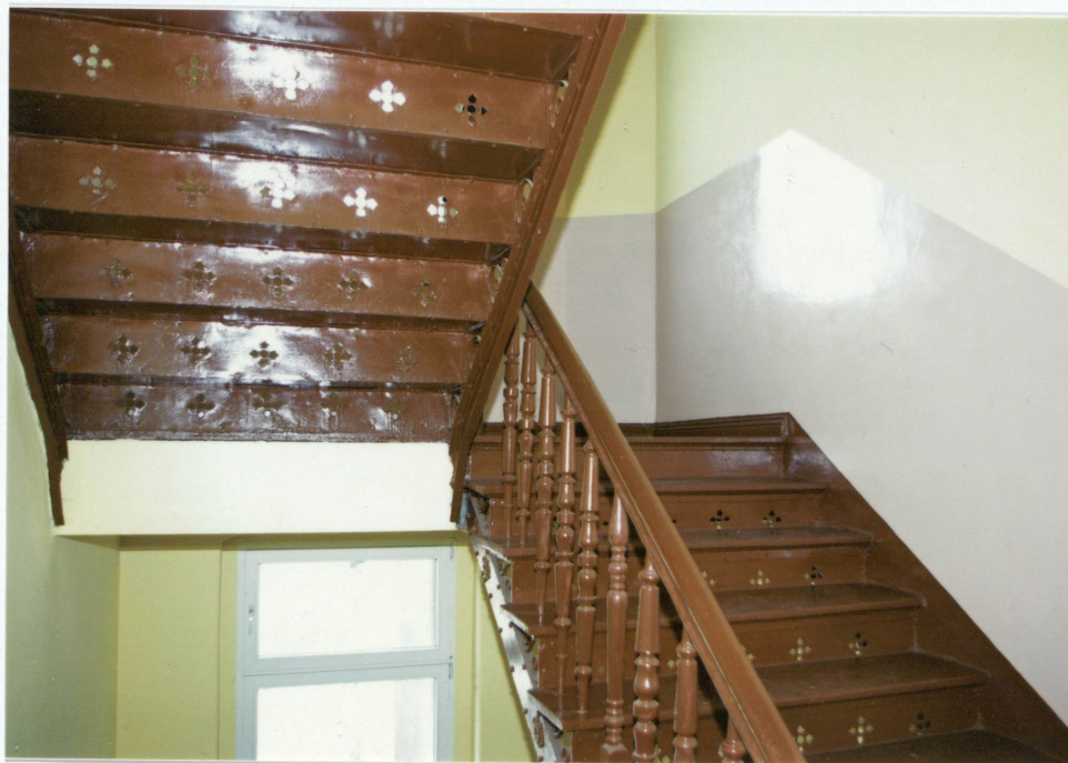
Stalowa konstrukcja schodów.
