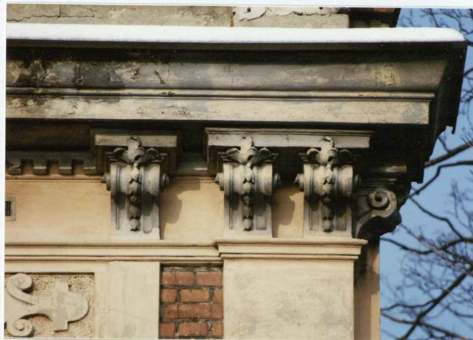
Kroksztyny wspierające gzyms okapowy.
