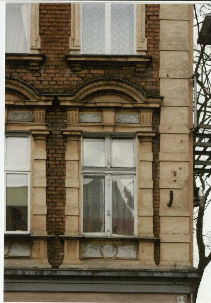
Okno z oryginalną stolarką w osi skrajnej II kondygnacji.
