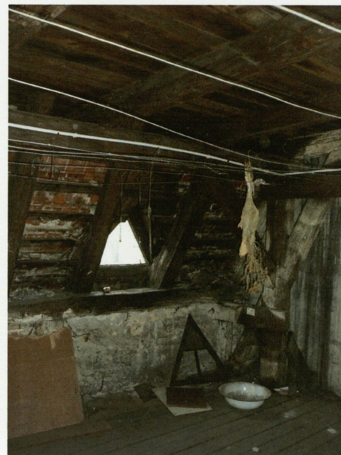
Konstrukcja dachu pulpitowego.
