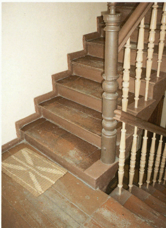
Toczony słup balustrady klatki schodowej.
