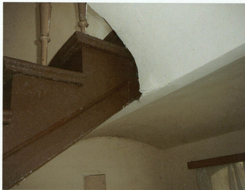
Łęk konstrukcyjny podestu klatki schodowej.
