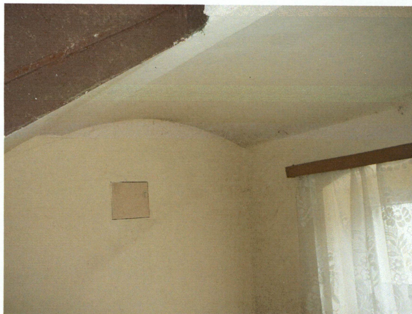
Łęk konstrukcyjny podestu klatki schodowej.
