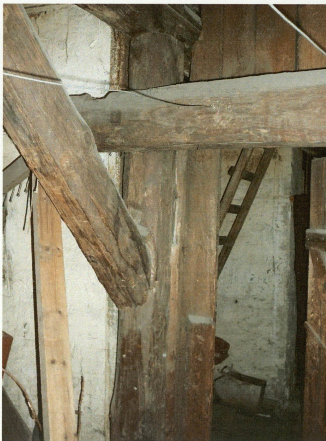
Słup z mieczami w konstrukcji więźby dachowej.
