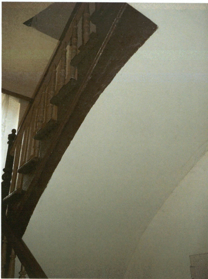
Murowana konstrukcja schodów.
