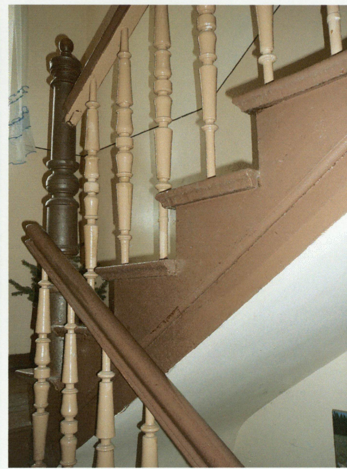
Tralkowa balustrada klatki schodowej.
