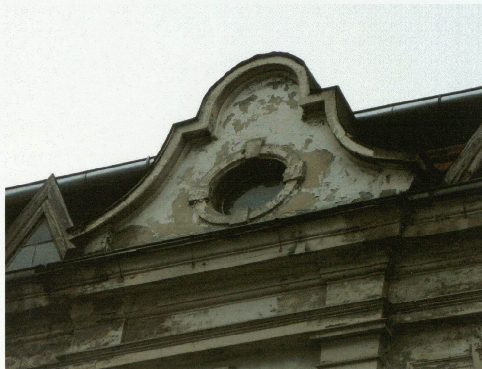
Zniszczenia w obrębie gzymsu koronującego i lukarny.
