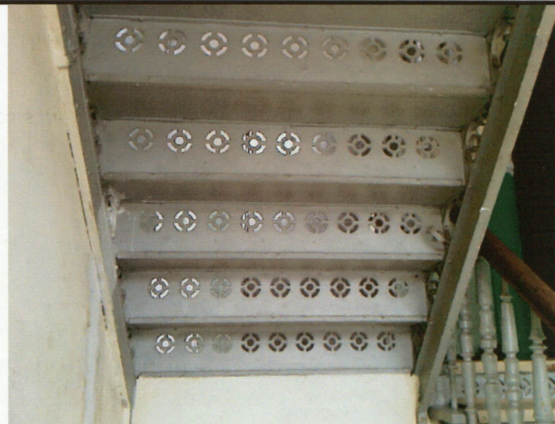
Stalowa konstrukcja schodów.
