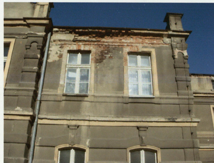
Zniszczenia wyprawy tynkarskiej pod okapem.
