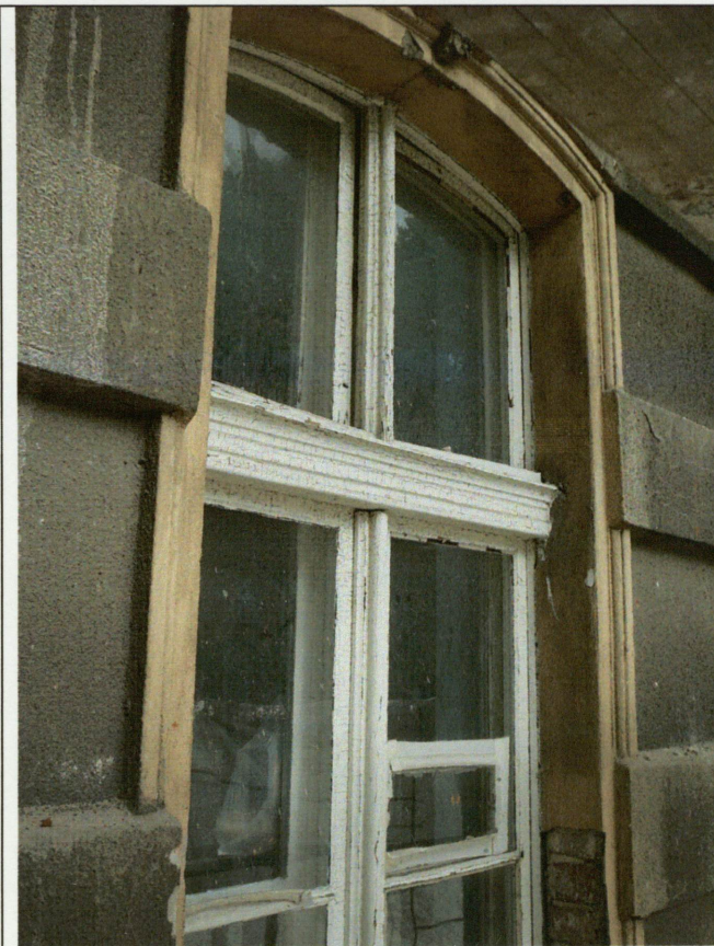
Profilowanie opaski okiennej w I kondygnacji.
