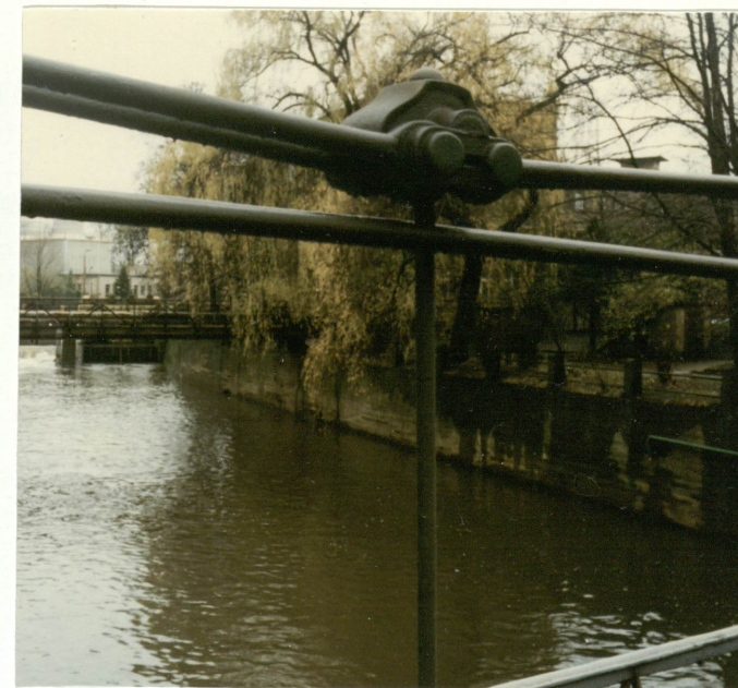
6. Konstrukcja zawieszenia wieszaka do cięgna, neg. 600/664/5
