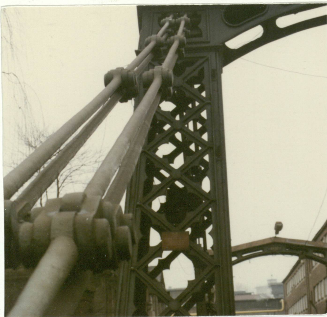
4. Słup pylonu i cięgna, neg. 400/499/3
