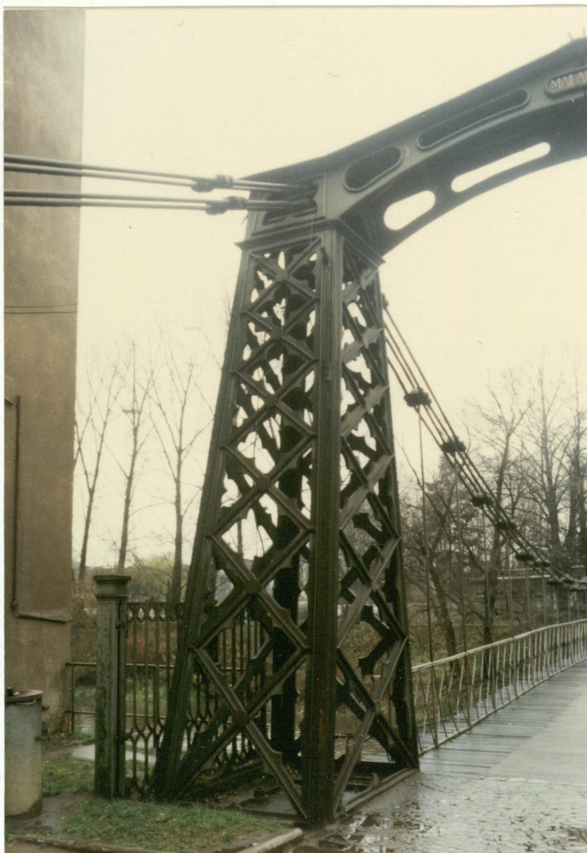
4/6. Konstrukcja żeliwna słupa-pylonu, neg. 400/498/6, 400/499/1 i 600/664/1
