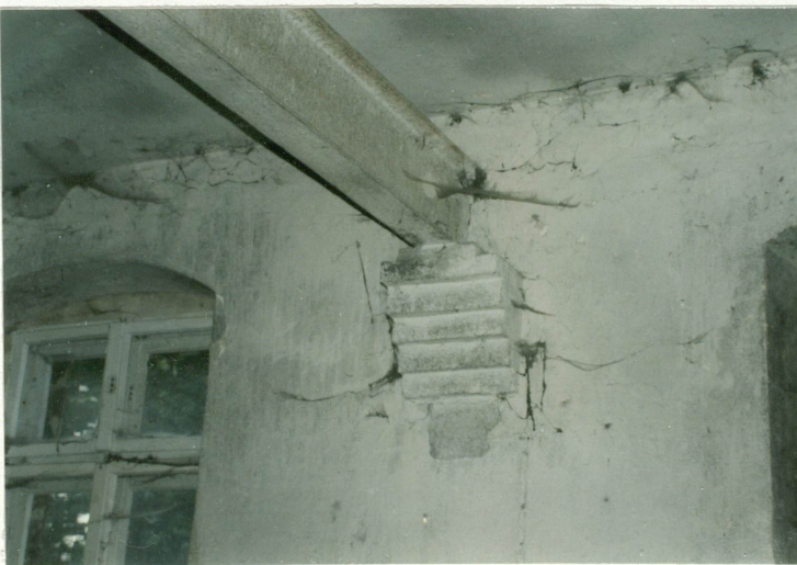
Oficina – wnętrze wozowni, wspornik podciągu
