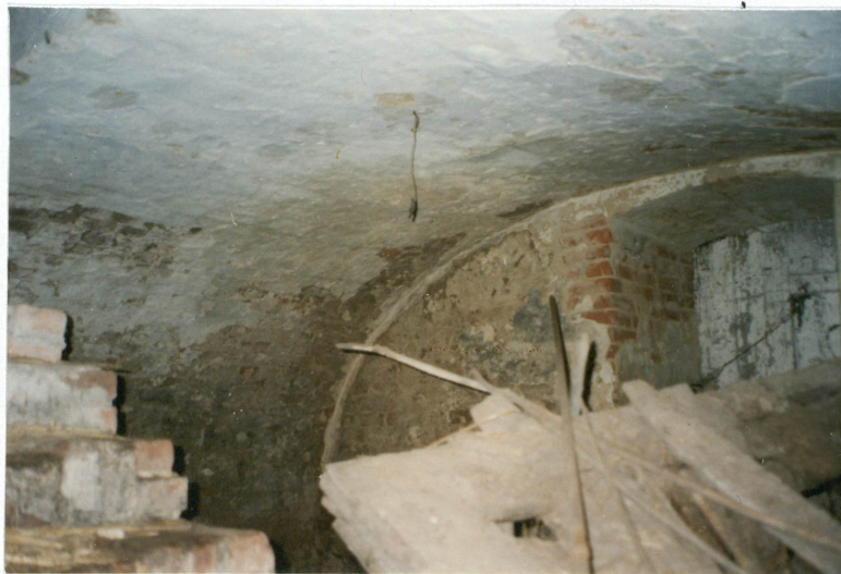
Sklepienie w piwnicy części starszej
