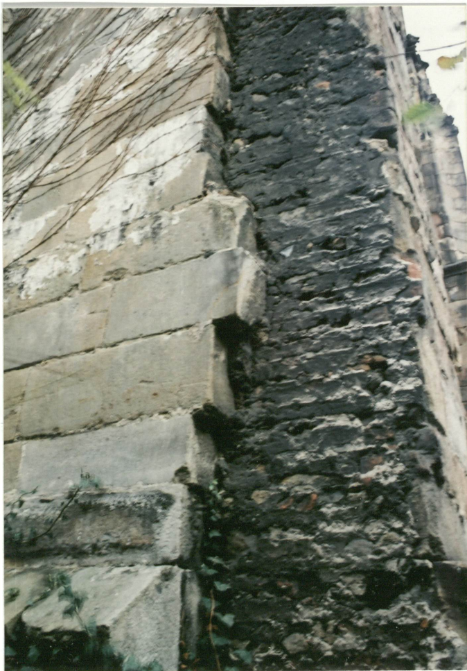
25. Odspojona okładzina naroża pn.-wsch.
