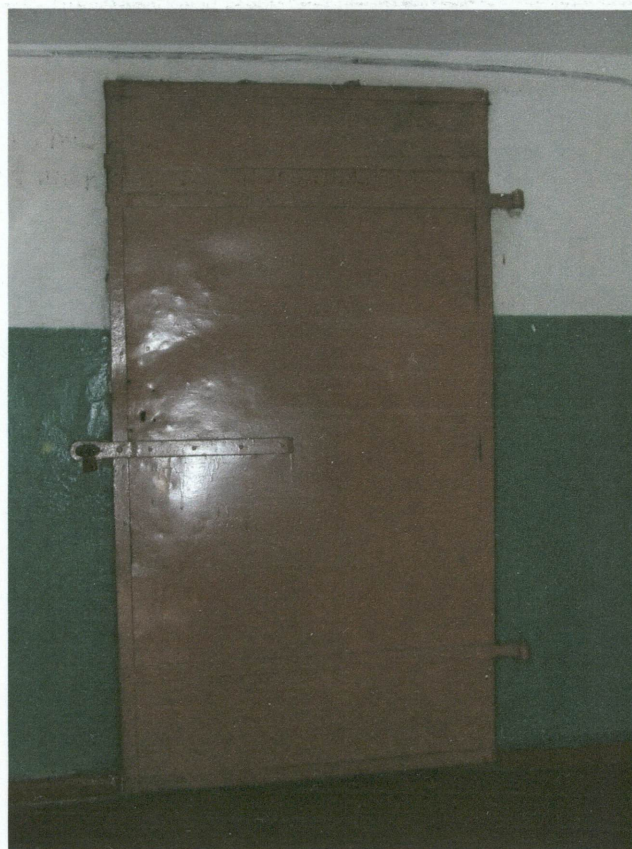
59. Drzwi p.poż. na strychowe poddasze
