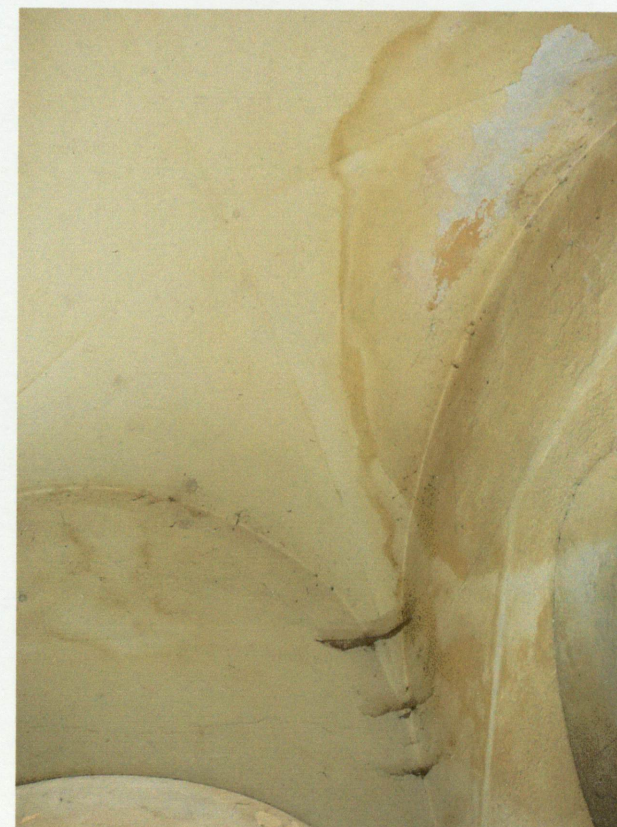
Sklepienie krzyżowe w podcieniu wejścia głównego.
