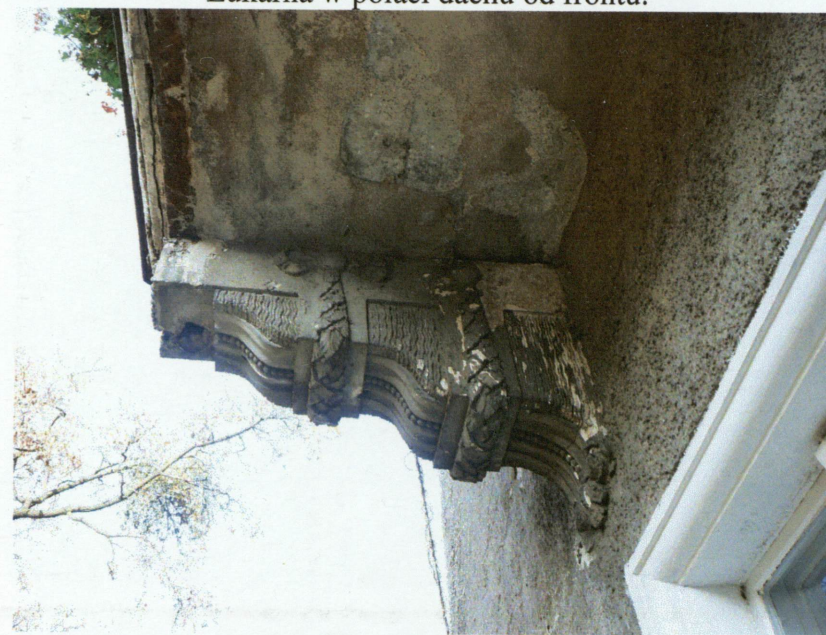
Konsola wspierająca balkon w elewacji frontowej
