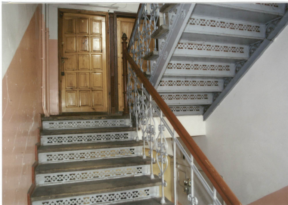
Stalowa konstrukcja klatki schodowej z ozdobnie wycinanymi podstopnicami i stalową balustradą.
