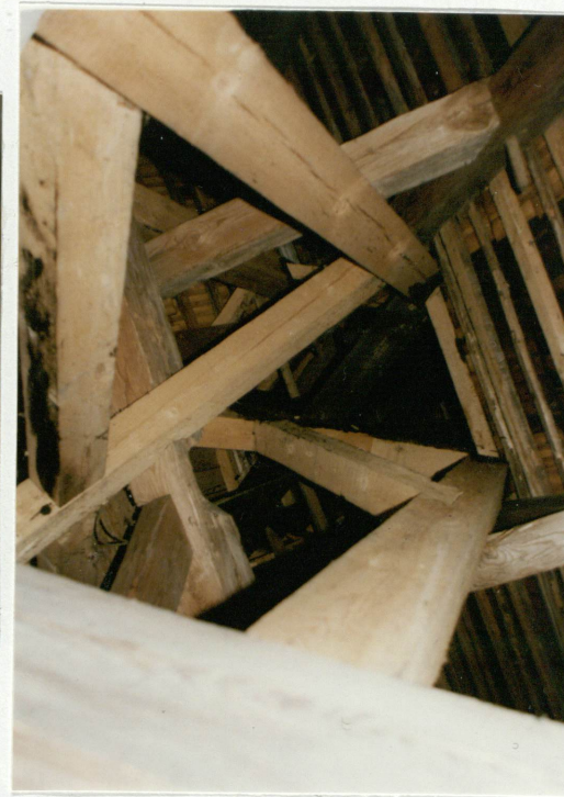
Konstrukcja wieżyczki na sygnaturkę Wieżba – fragment
