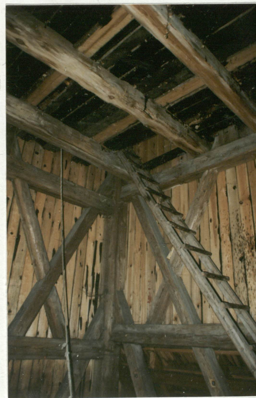
Konstrukcja wieżyczki na sygnaturkę Wieżba – fragment
