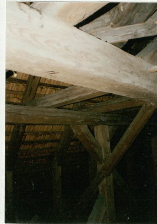
Konstrukcja wieżyczki na sygnaturkę Wieżba – fragment
