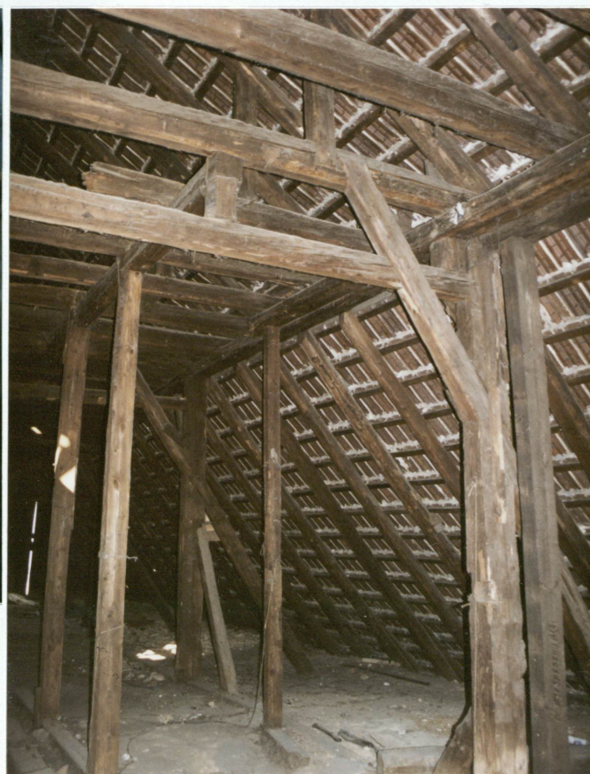
Więźba dachu mansardowego w skrzydle pn. →
