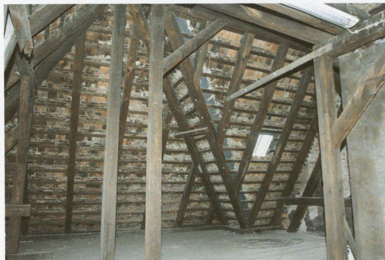
Konstrukcja drewnianej więźby dachowej.
