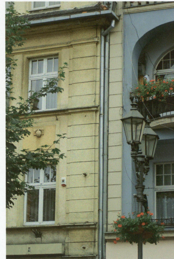
Zdwojona, pasowo boniowana lizena w elewacji frontowej.
