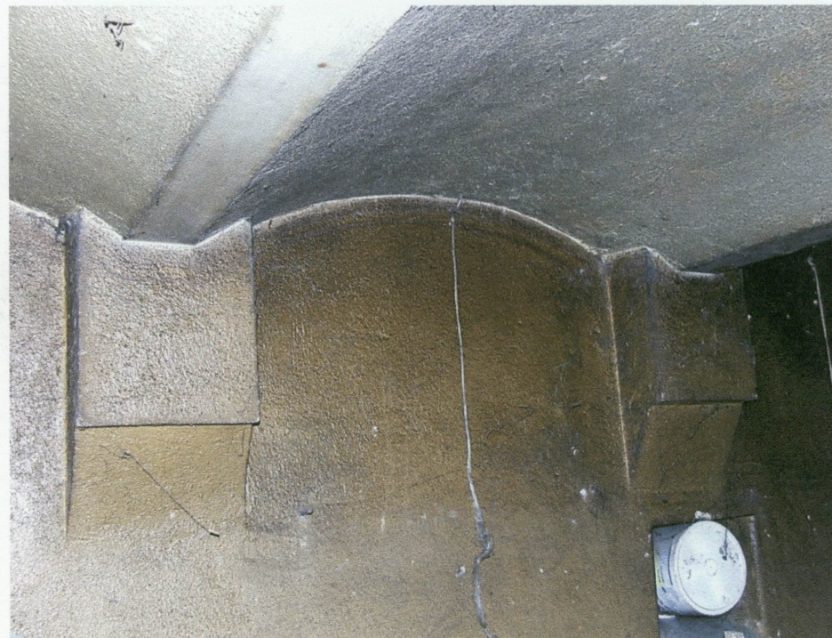
74. Konsoly wspierające belki stropu w suterenie w części wyższej 76. Piwnica w części niższej
