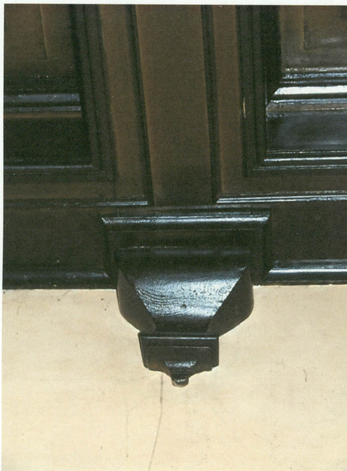
59. Konsola wspierająca belkę stropu w mieszkaniu na parterze części wyższej
