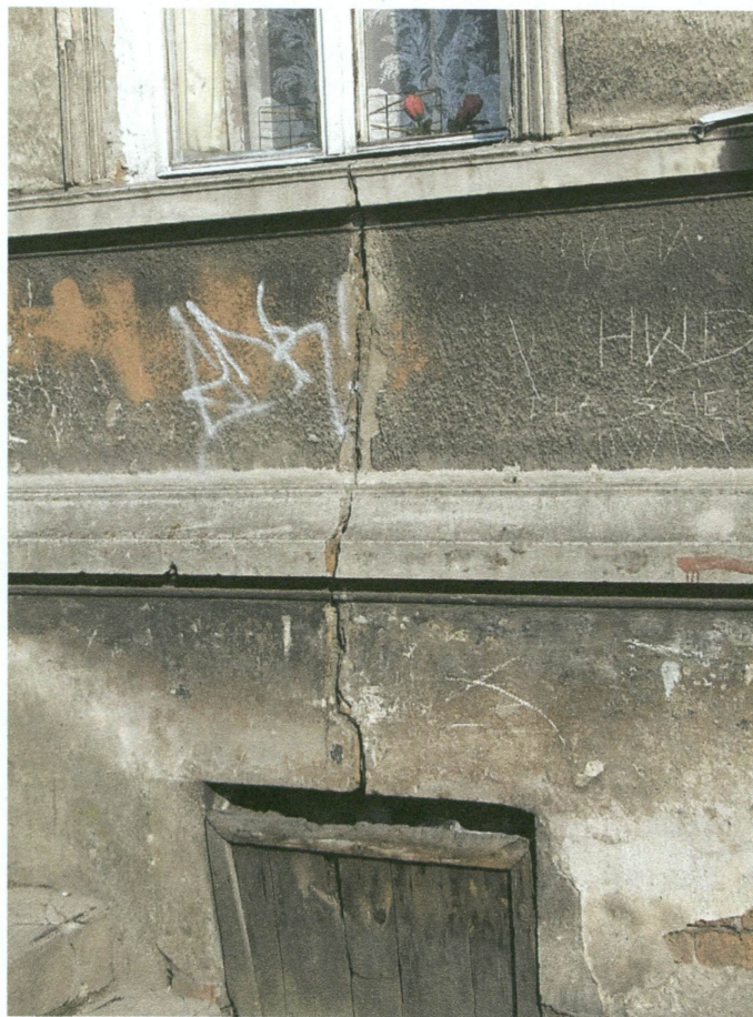
13. Elewacja zach. - pęknięcie muru w przyziemiu
