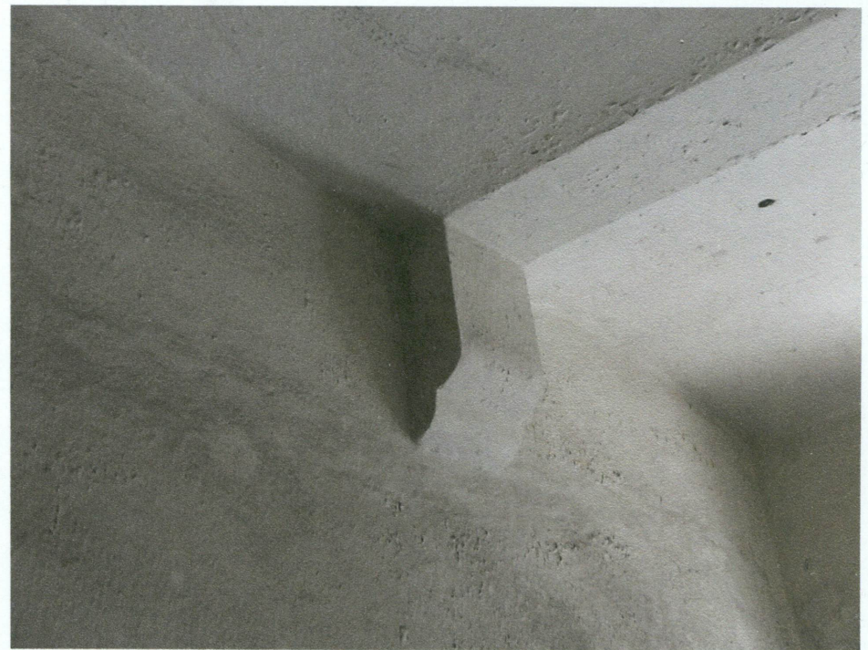
29. Konsola wspierająca belkę stropu odcinkowego we frontowej części sieni.
