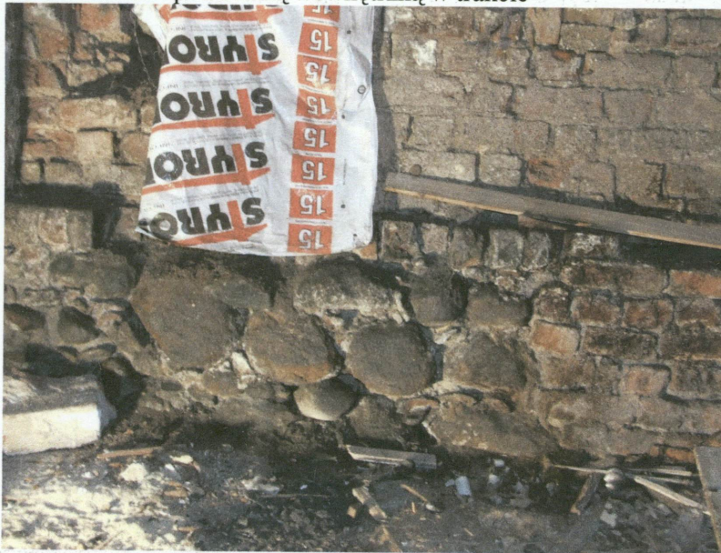
45. Fundament pod ścianą wewnętrzną w trakcie
