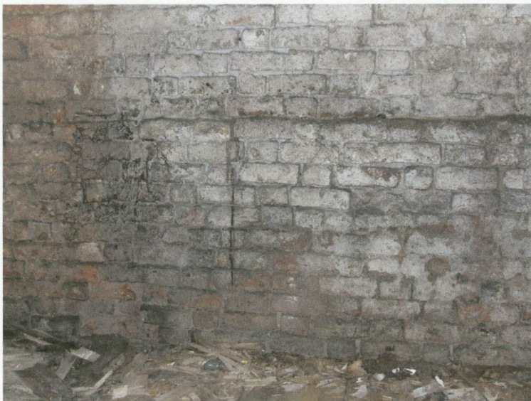
46. Jednowozówkowy watek ceglany ściany zach. w piwnicy w narożniku pd.-zach.
