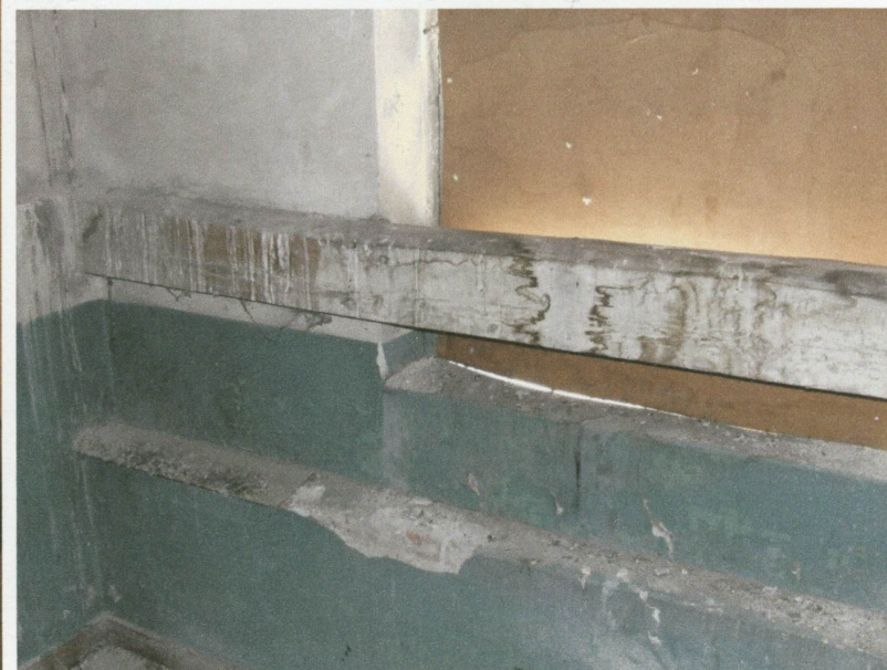
60. Drewniany ściąg na 3 półpiętrze klatki schodowej
