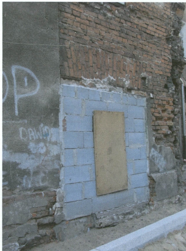
23. Elewacja pd. – zamurowane drzwi
