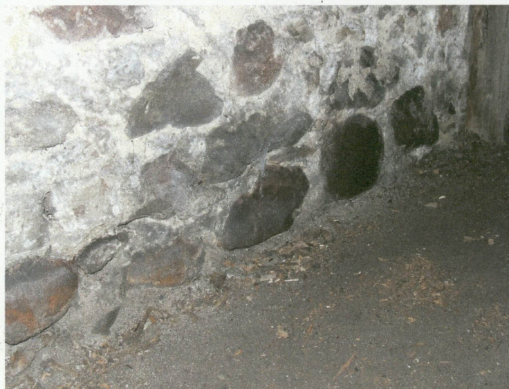
40. Fundament pod ścianą wewnętrzną w trakcie środkowym.
