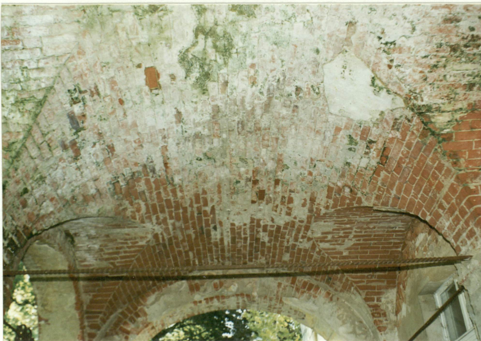
15 Sklepienie werandy południowej /28/ - widok ogólny w kierunku zachodnim - kolebka na łuku koszowym, z dwoma parami lunet.
