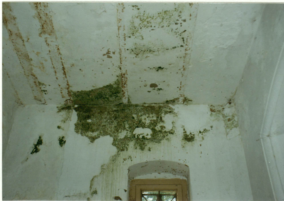
17 Strop typu Kleina nakrywający przedsionek /1/ - widać rdzewiejące belki stalowe. Strop silnie zawilgocony, pokryty glonami.
