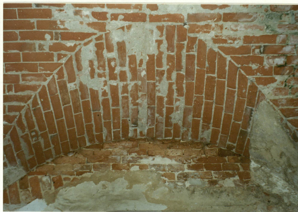
16 Fragment sklepienia werandy południowej /28/ - północno-zachodnia luneta; cegła lunety różni się od cegły ściany - widać że weranda została dobudowana później.
