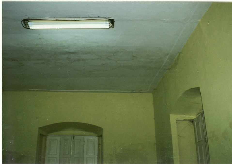
18 Wnętrze pomieszczenia narożnego pd.-zachodniego na parterze /7/ - widok w kierunku południowym na sufit z płaską ramą, która tu ma tylko zaokrąglone narożniki (por. fot.19,20).
