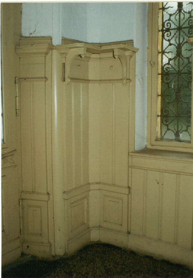
10 Wnętrze przedsionka /1/ - fragment boazerii drewnianej z gzymsem na konsolach.
