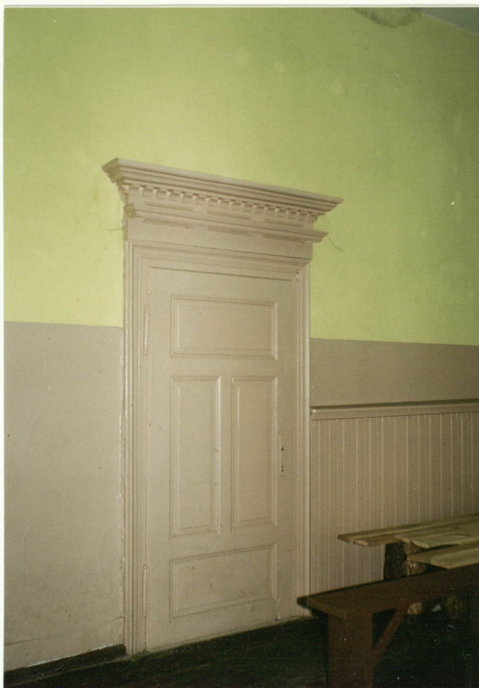
11 Fragment wnętrza /8/ na parterze na ścianie wewnętrznej przyległej do wnętrza /10/ - nowsza boazeria.
