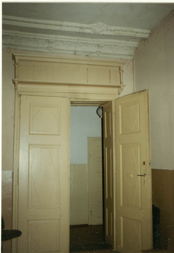
83 Drzwi do korytarza środkowego z opaskami wokół szpalet, z architektoniczną supraportą, dwuskrzydłowe, symetryczne, ramowo-płycinowe. Wnętrze podzielono wtórnie ścianą działową.
