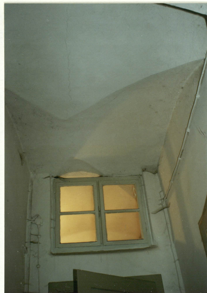
12 Wnętrze pomieszczenia /14/ widok na dzioby dwóch lunet sklepienia kolebkowego; nad drzwiami do pomieszczenia /16/ okno.
