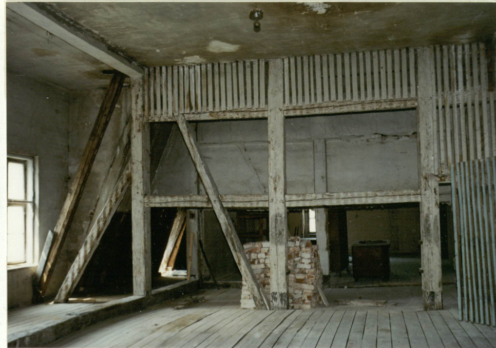
92 Ściany konstrukcji ryglowej - w trakcie południowym - widok na ścianę zachodnią.
