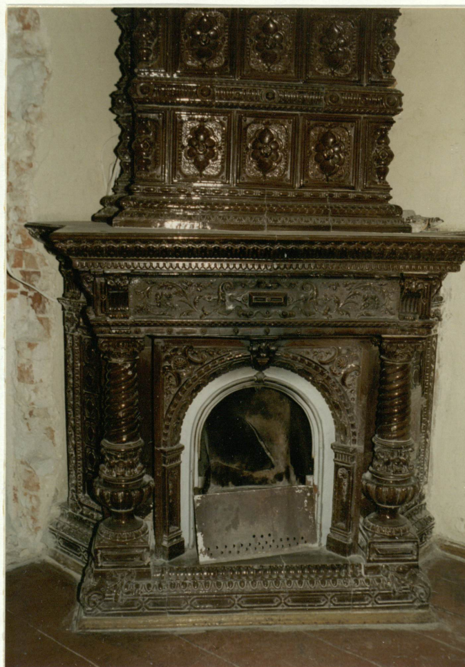
74 Dolna kondygnacja pieca → palenisko jak w kominku.
