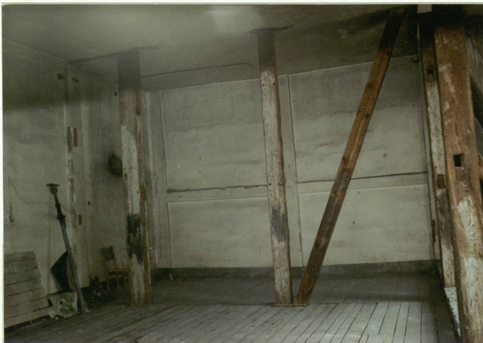
91 Ściany konstrukcji ryglowej - w trakcie połud- niowym - widok na ścianę wschodnią.
