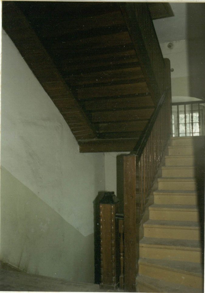
59 Fragment klatki schodowej /3/ od piętra do użytkowego poddasza: dwa różne słupki balustrad przy schodach do I piętra i przy schodach do poddasza.
