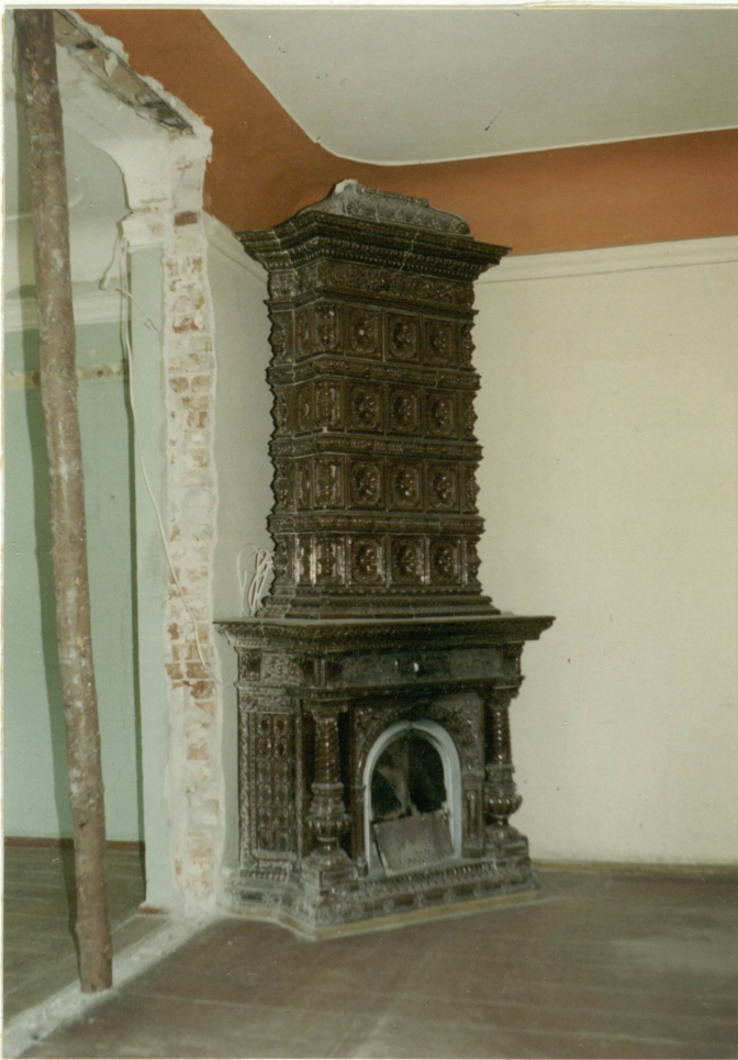
73 W środkowym pomieszczeniu traktu południowego na piętrze w narożniku pn.-zach. stoi piec narożny ustawiony przekątniowo - kaflowy, dwukondygnacyjny.
