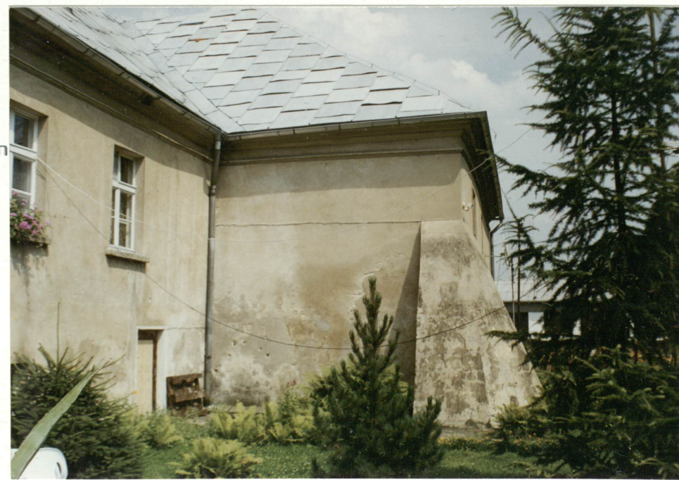
5 Fragment elewacji południowej → szkarpa przy południowo-zachodnim narożniku części wschodniej.
