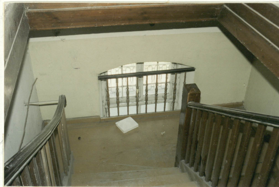
61 Balustrada schodów klatki schodowej /3/ w oknie - z cienkich tralek toczonych (podeśt pomiędzy piętrem i poddaszem).
