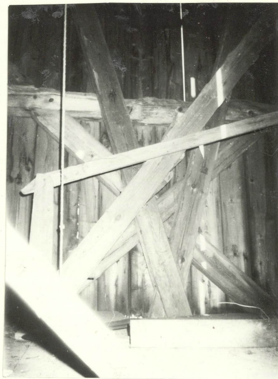
Elementy konstrukcji słupowej wieży
