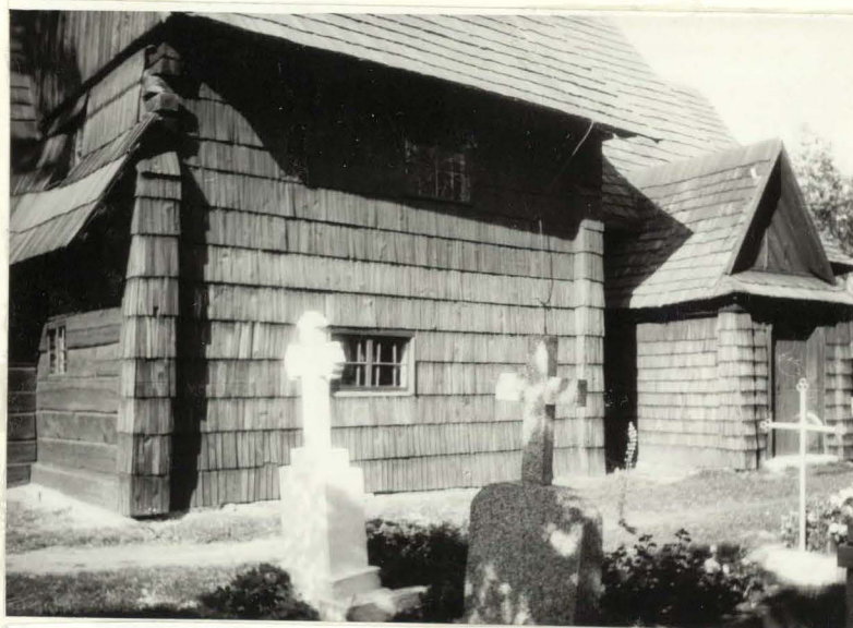
Elewacja południowa. Szczegóły obicia gontowego
