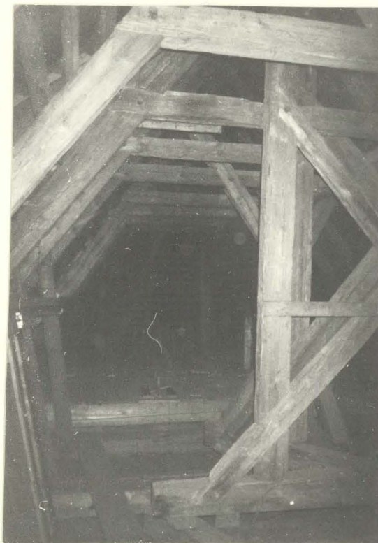
Nawa, więźba dachowa, konstrukcja sygnaturki
