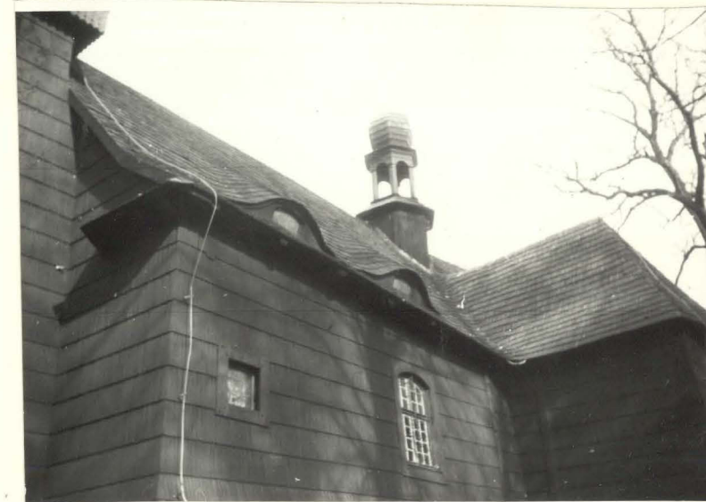
Elewacja połudn.-okna w połaci dachowej "w ole oczy"
