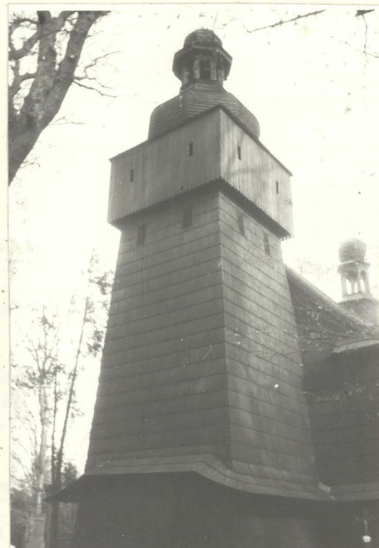
Elewacja zachodnia -wieża; izbica z hełmem ; okap obiegający korpus
