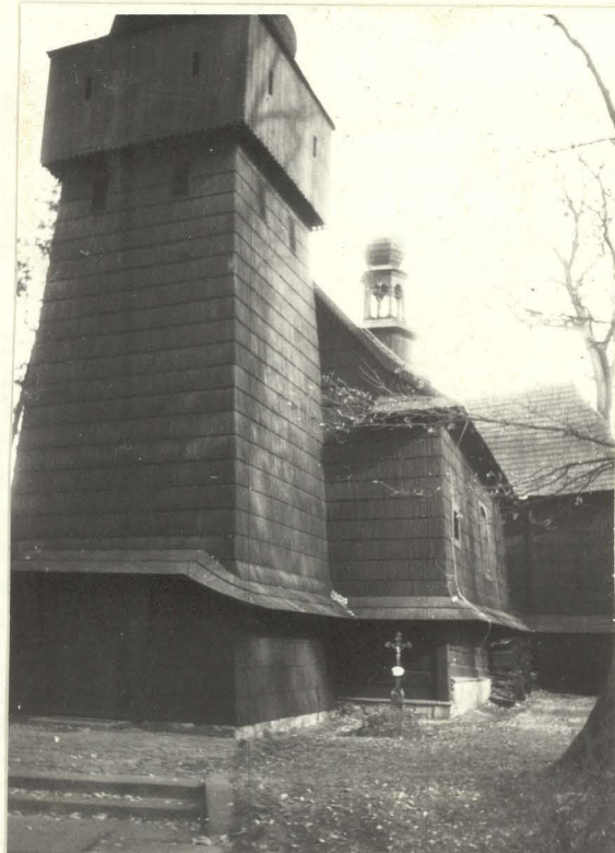
Elewacja zachodnia -wieża; izbica z hełmem ; okap obiegający korpus
