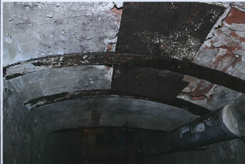
j.w. – wzmocnienie sklepienia
