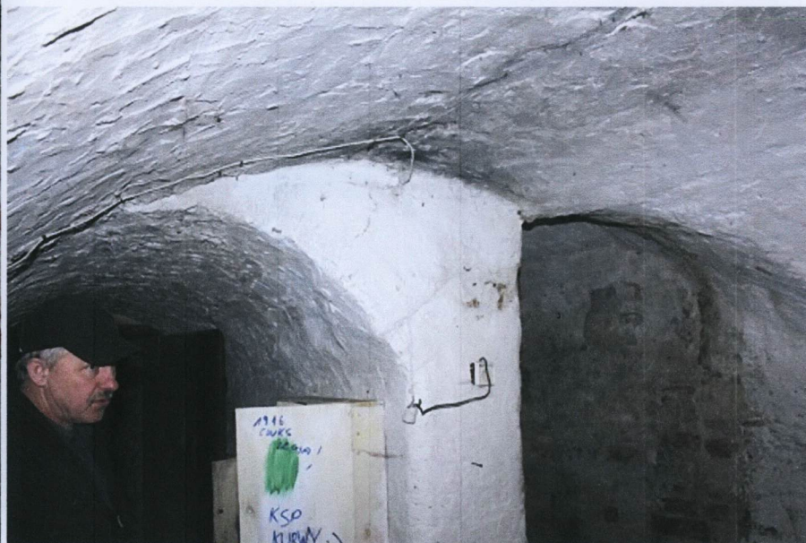
j.w – komora ze zdublowanym sklepieniem kolebkowym
