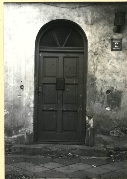
Elewacja zach., Zniszczone obramienie portalu w segmencie nr nr 2
