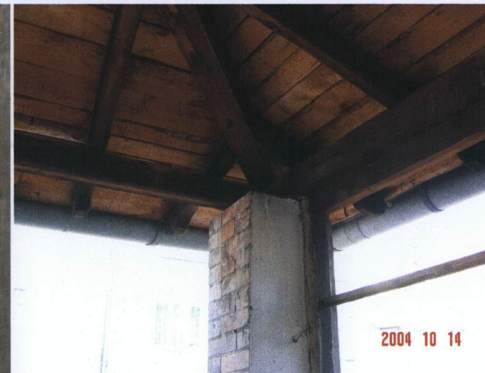
Konstrukcja zadaszenia loggii (fot. Archiwum WUOZ, 2004)
