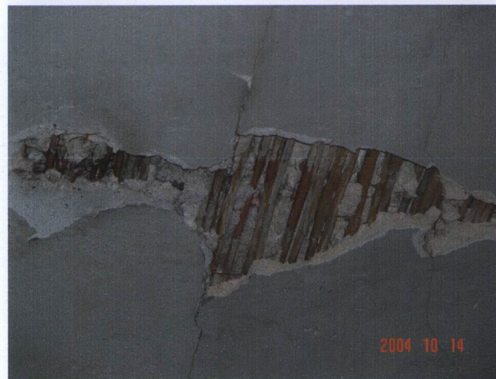
Ubytki skorodowanego tynku ułożonego na trzcinnie (fot. Archiwum WUOZ, 2004)
