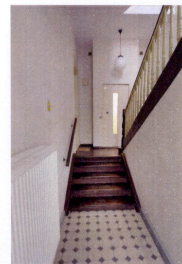
klątka pomocnicza skrzydła północnego (nr IV): stolarka drzwiowa, posadzka przedsionka, ballustrada i lastrykowe wykończenie spocznika; widok dolnego biegu
