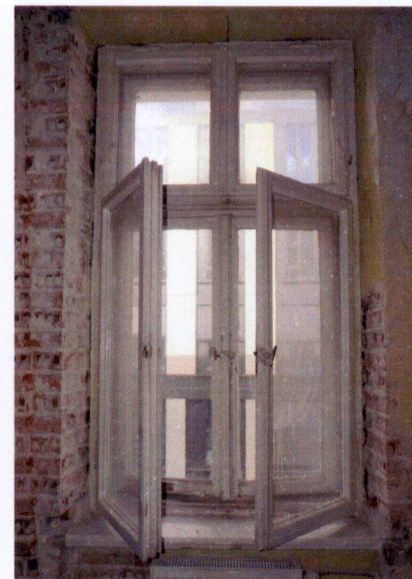
u góry: wnętrza pustostanów po samowolnych pracach budowlanych (lokale IV p. skrzydła frontowego) przykłady stolarki drzwiowej w lokalach mieszkalnych oraz przykłady stolarki okiennej skrzynkowej; dekoracyjny piec kaflowy w lokalu frontowym
