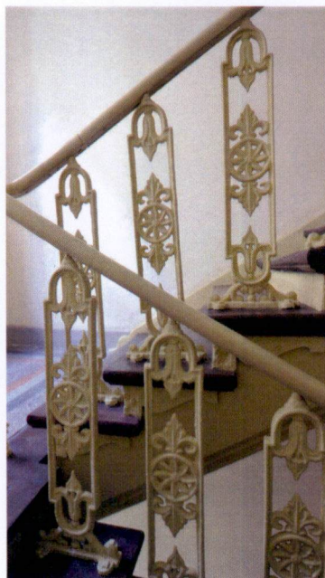
klątka pomocnicza skrzydła północnego (nr IV): stolarka drzwiowa, posadzka przedsionka, ballustrada i lastrykowe wykończenie spocznika; widok dolnego biegu
