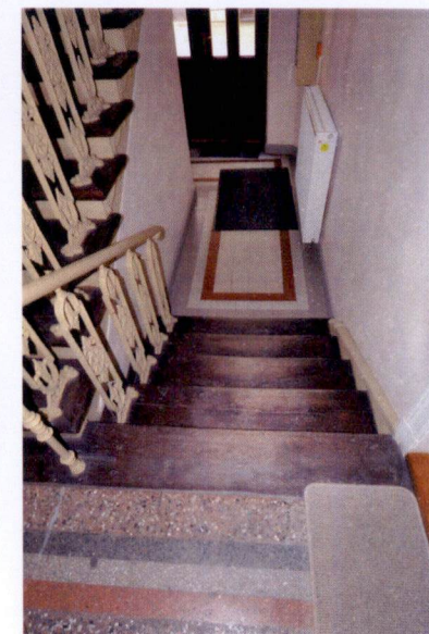
klątka pomocnicza skrzydła północnego (nr IV): stolarka drzwiowa, posadzka przedsionka, ballustrada i lastrykowe wykończenie spocznika; widok dolnego biegu
