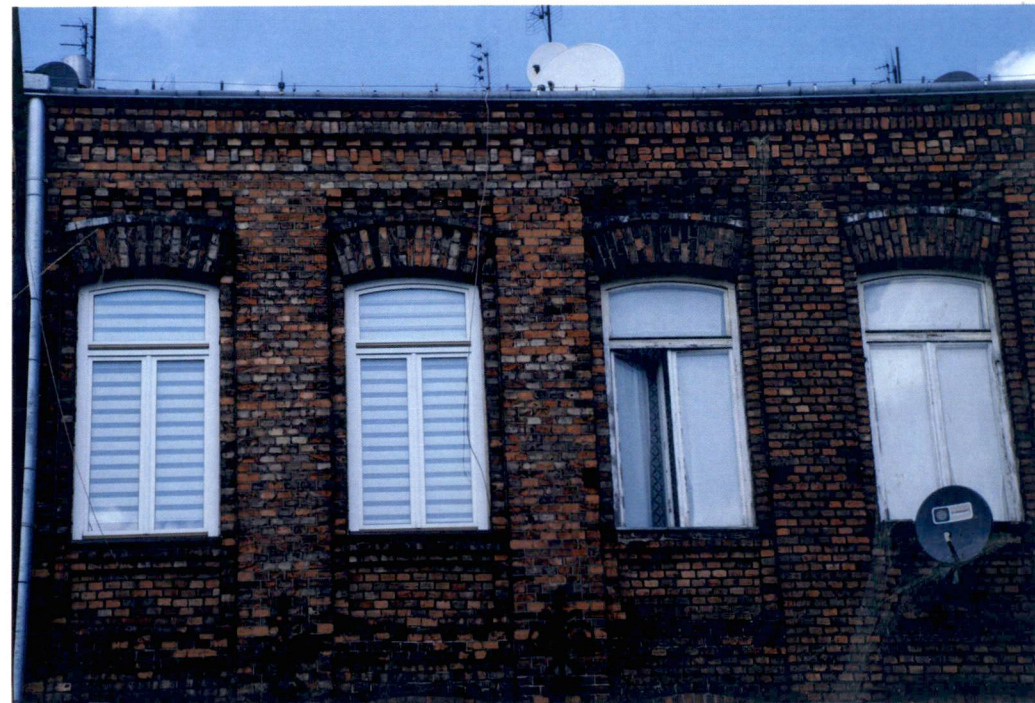
8. Fragment elewacji południowej - otwory okienne. Na zdjęciu część zachodnia z oryginalnie zachowanym murem, w części wschodniej widoczne ślady powojennej odbudowy, z niepełnym spoinowaniem cegieł.
