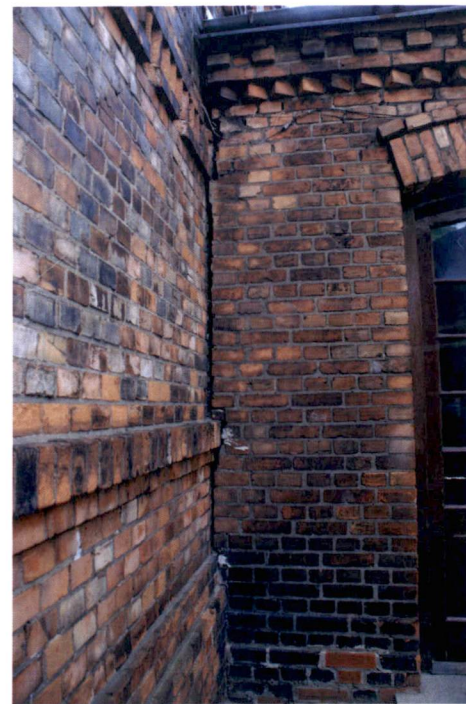
8. Przybudówka (od str. zachodniej elewacji budynku) - widok od podwórza; widoczny brak przewiązania cegieł w murze z członem budynku głównego oraz w połowie długości przybudówki
