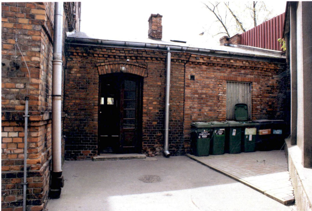
8. Przybudówka (od str. zachodniej elewacji budynku) - widok od podwórza; widoczny brak przewiązania cegieł w murze z członem budynku głównego oraz w połowie długości przybudówki
