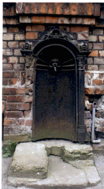
4. Historyczne zewnętrzne ujęcie wody w żeliwnej, dekoracyjnej oprawie (elewacja północna)
