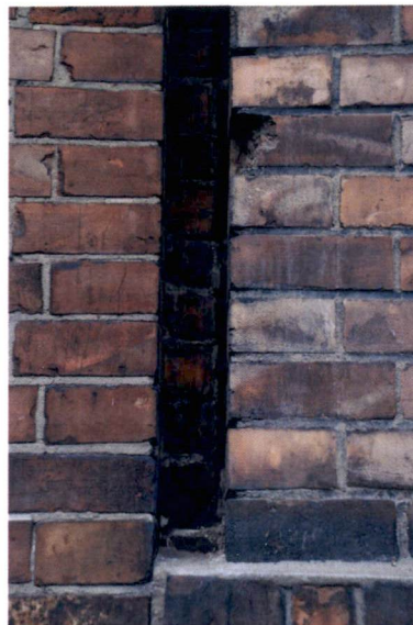
10. Przybudówka (od strony zachodniej elewacji budynku) - widok od ul. Ząbkowskiej; widoczny brak przewiązania cegieł w murze z członem głównym budynku
