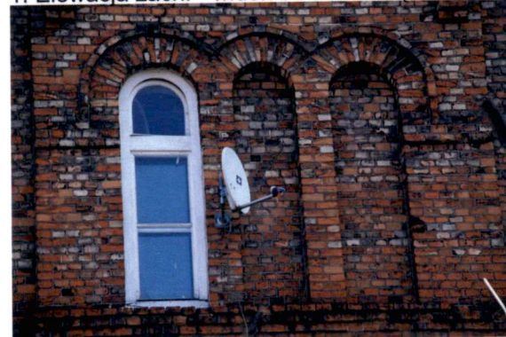
2. Fragment elewacji zachodniej - otwór okienny w formie triform z dwiema blendami
