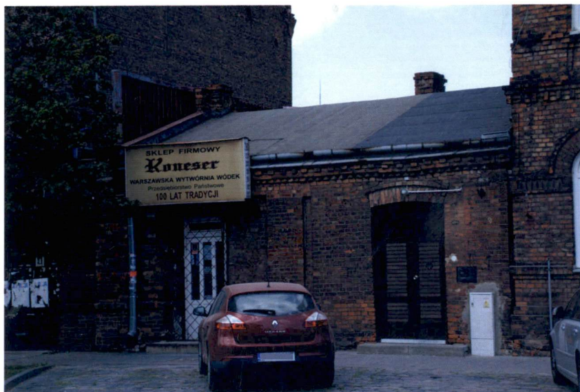
10. Przybudówka (od strony zachodniej elewacji budynku) - widok od ul. Ząbkowskiej; widoczny brak przewiązania cegieł w murze z członem głównym budynku
