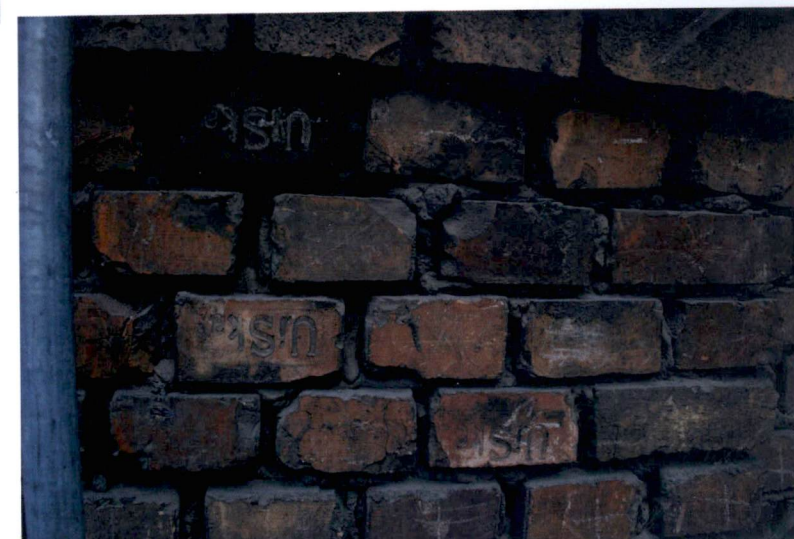
7. Fragment elewacji południowej (odbudowanej) - cegła ze stemplem U.Ska
