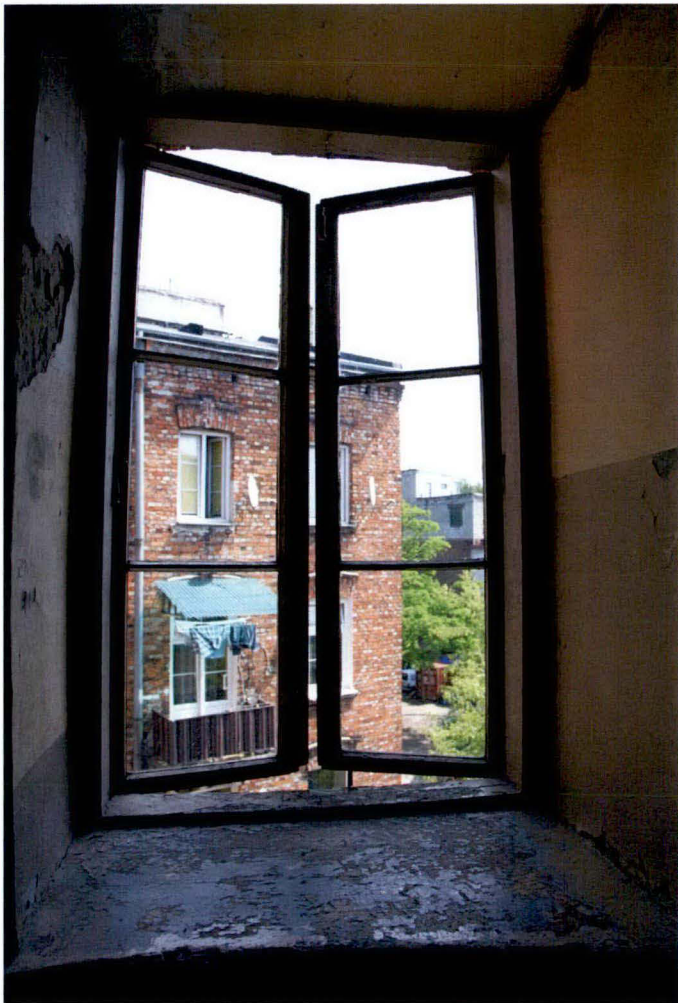
Zachodnia klatka schodowa: okno na klatce schodowej (brak skrzydeł zimowych)
