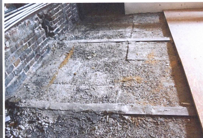
strop Kleina nad ostatnią kondygnacją
