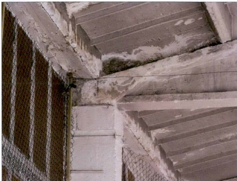
Żelbetowe elementy prefabrykowane stropu wsparte na słupie.
