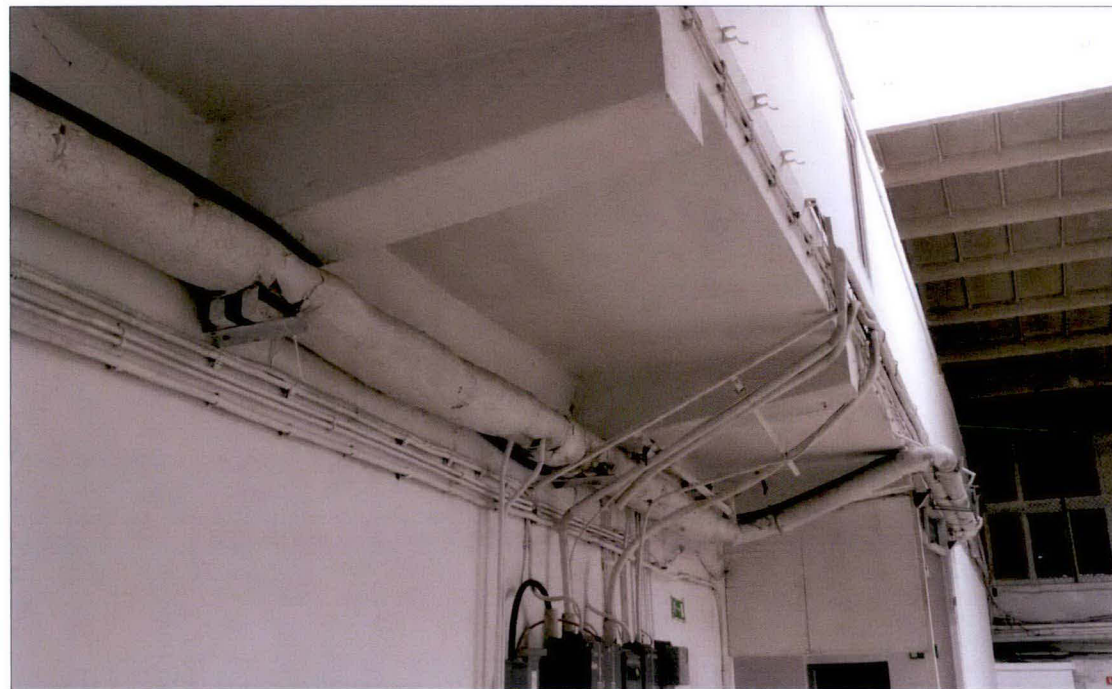
Monolityczne wsporniki antresoli dobudowanej wtórnie po 1966 r. w północno-wschodniej części hali.
