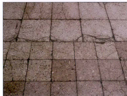
Płytki lastryko różnej wielkości, gradacji ziaren i wybarwieniu w posadzce hali.
