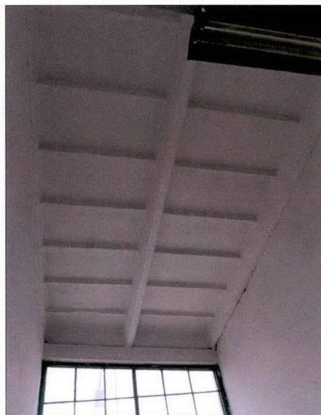
Konstrukcja stropu nad klatką schodową i pomieszczeniem na antresoli wykonane z żelbetowych prefabrykatów.
