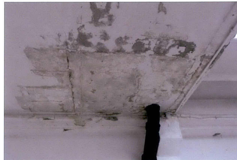
Uszkodzenia stropu (typu DMS) spowodowane nieszczelnością rury spustowej, odprowadzającej wody opadowe.
