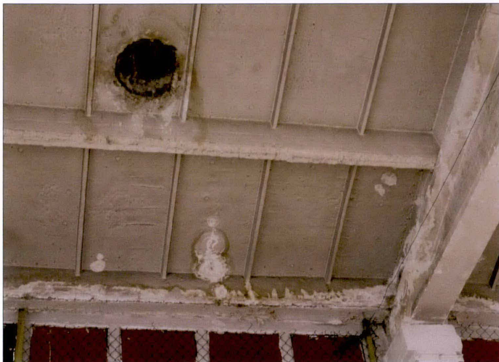
Uszkodzenia płyt panwiowych w wyniku zawilgocenia na styku ze ścianą i słupem.
