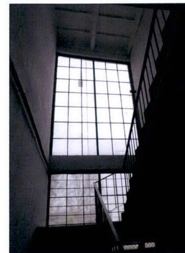
Klatka schodowa. Widok z kondygnacji I piętra, na podest półpiętra oraz kondygnacji I piętra. Widoczna konstrukcja stropu oraz przypuszczalnie oryginalne przeszklanie w ścianie wschodniej.
