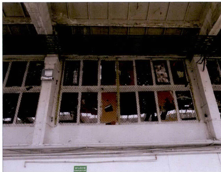
Pomost podtrzymujący przewody elektryczne pod stropem w południowej części hali.
