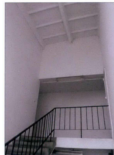
Klatka schodowa. Widok z kondygnacji I piętra, na podest półpiętra oraz kondygnacji I piętra. Widoczna konstrukcja stropu oraz przypuszczalnie oryginalne przeszklanie w ścianie wschodniej.
