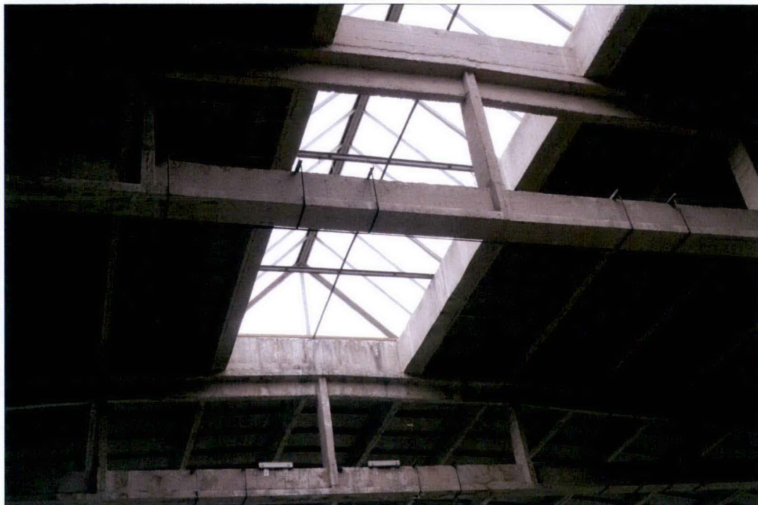
Świetlik z wtórnym przeszkleniem w postaci płyt poliwęglanowych nad halą główną, fragment zachodni.
