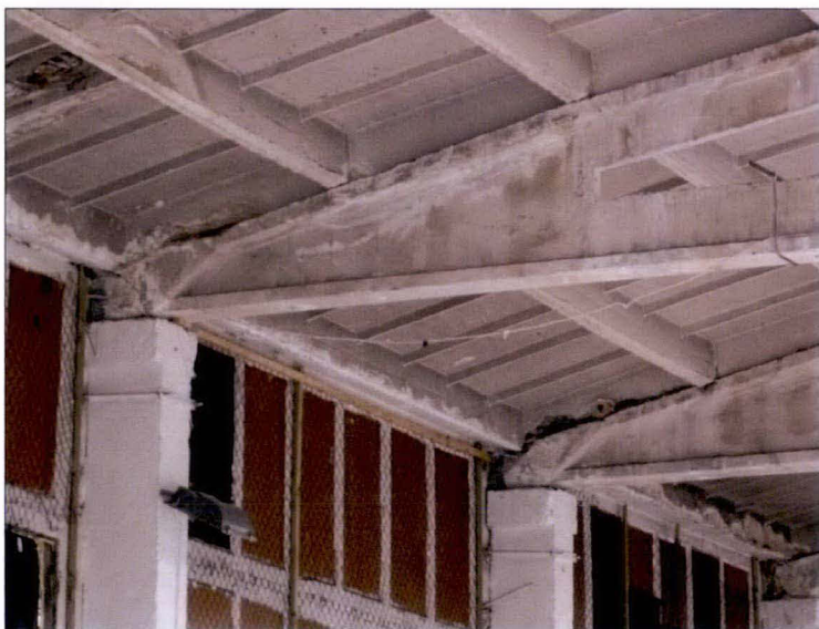
Elementy konstrukcji stropu hali. Widoczne uszkodzenia na skutek przenikania wody opadowej.
