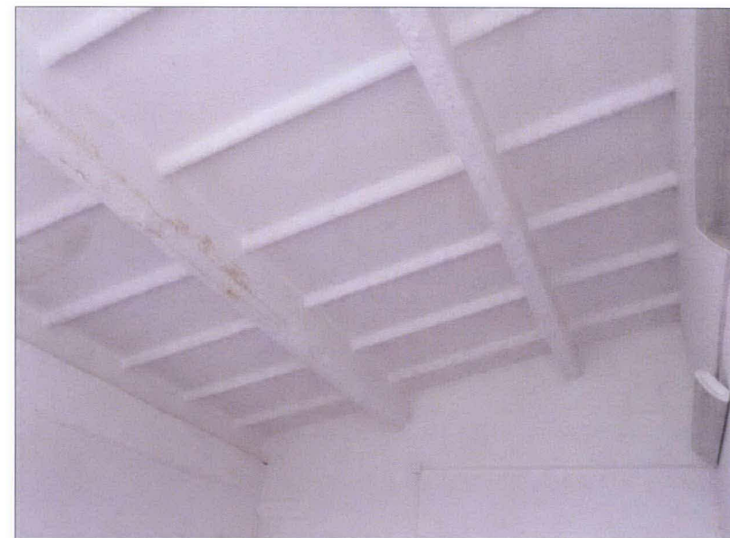
Konstrukcja stropu nad klatką schodową i pomieszczeniem na antresoli wykonane z żelbetowych prefabrykatów.
