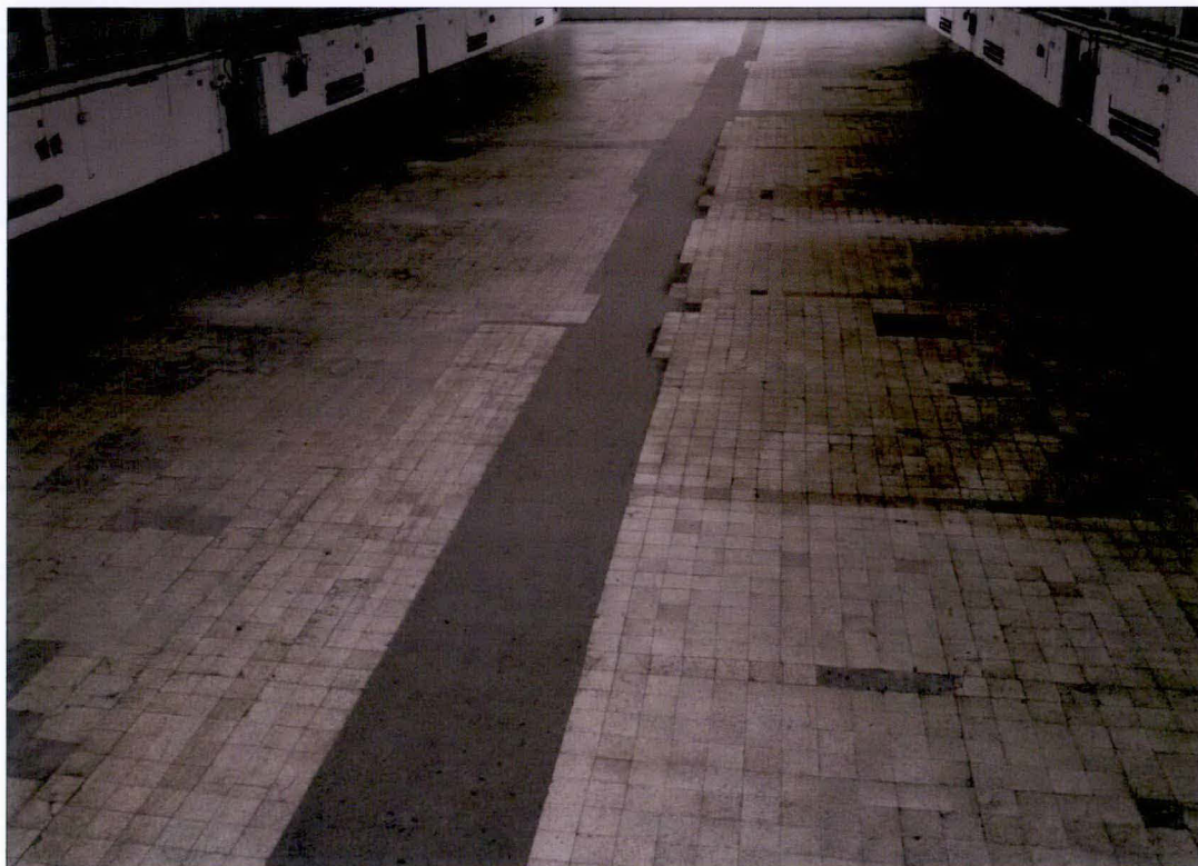
Wtórna posadzka hali wykonana z różnej wielkości kwadratowych płytek lastryko.
