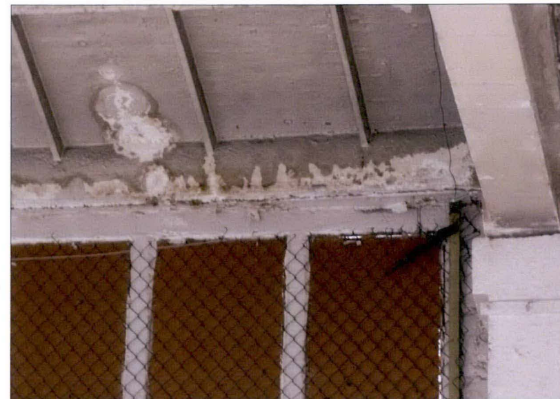
Fregment prefabrykatu okiennego na styku z konstrukcją wsporczą dachu w postaci żelbetowych płyt panwiowych i dźwigara KBOS-24.
