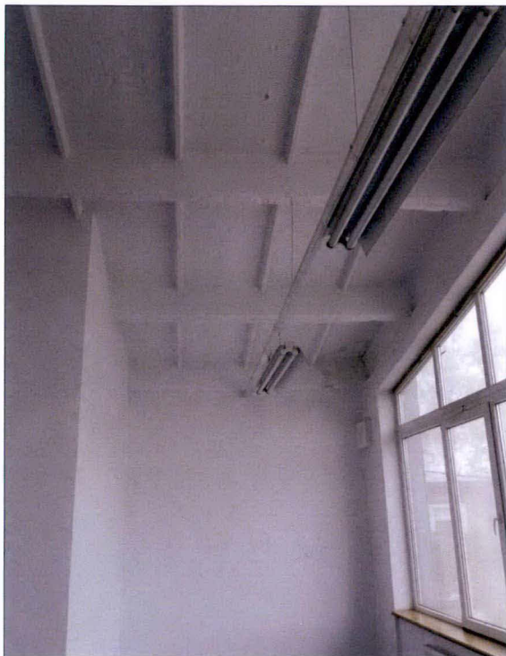
Pomieszczenie na antresoli w północnym narożu budynku. Widoczna konstrukcja wsporcza dachu wykonana z płyt panwiowych (żebrowych).
