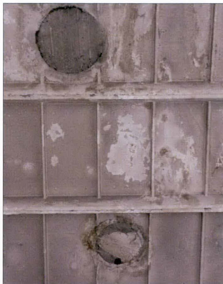
Ślady po pierwotnych otworach wentylacyjnych w stropie hali.
