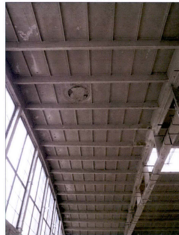
Strop z elementów prefabrykowanych w południowo-zachodniej części hali.
