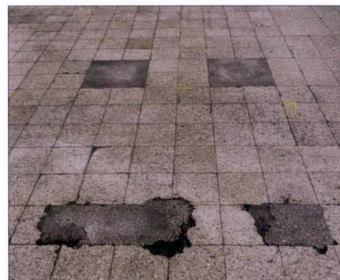
Ślady w posadzce hali najprawdopodobniej po fundamencie maszyny.
