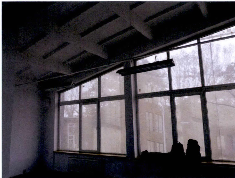
Pomieszczenie na antresoli w północnym narożu budynku. Widoczna konstrukcja wsporcza dachu wykonana z płyt panwiowych (żebrowych).
