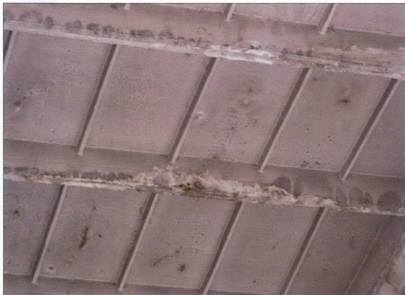
Strop z elementów prefabrykowanych; widoczne uszkodzenia spowodowane przesiąkaniem wody opadowej.
