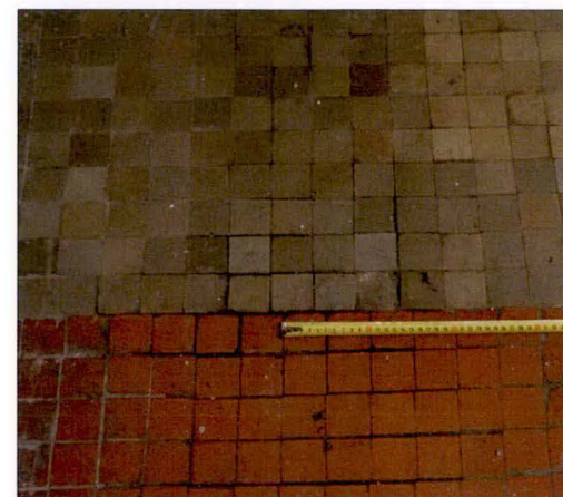
Płytki lastryko różnej wielkości, gradacji ziaren i wybarwieniu w posadzce hali.
