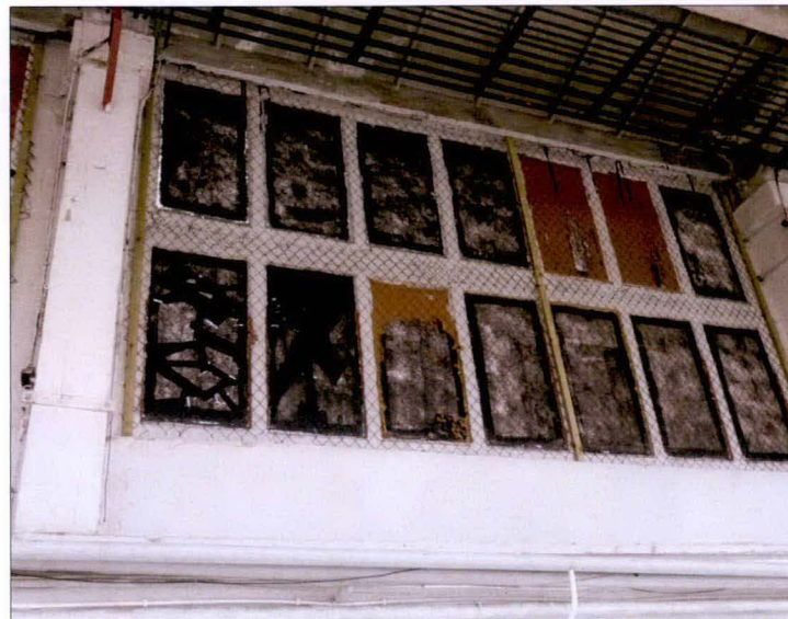
Segmenty okien doświetlających wtórnie prowizorycznie zamalowane. Każdy z segmentów składa się z dwóch prefabrykatów okiennych po siedem otworów okiennych.
