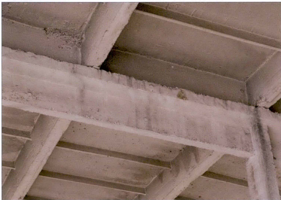
Pas górny dźwigara KBOS-24, na którym oparte są płyty panwiowe (żebrowe).
