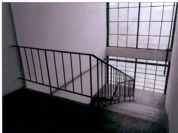
Klatka schodowa. Widok z kondygnacji I piętra, na podest półpiętra oraz kondygnacji I piętra. Widoczna konstrukcja stropu oraz przypuszczalnie oryginalne przeszklanie w ścianie wschodniej.
