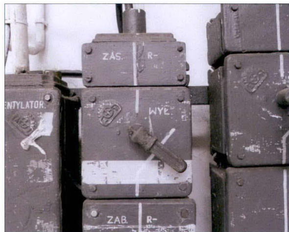
Urządzenia pomiarowe i kontrolne instalacji elektrycznej (ściana północno-zachodnia i północno-wschodnia).
