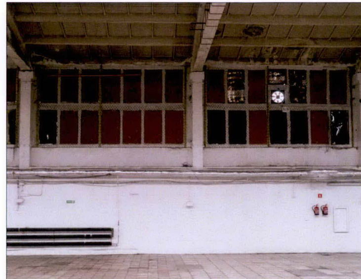
Segmenty okien doświetlających wtórnie prowizorycznie zamalowane. Każdy z segmentów składa się z dwóch prefabrykatów okiennych po siedem otworów okiennych.
